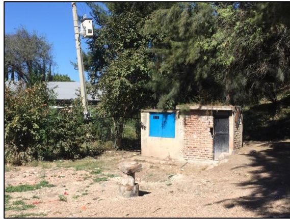
Ilustración 3 Estado actual de las instalaciones pozo por equipar.
