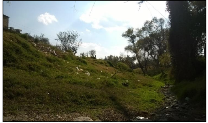
Foto 4 Zona Federal del Canal de Riego.
