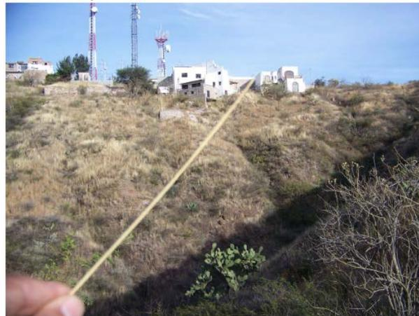
Flanco NW mostrando rompimiento del túnel y su proyección en superficie
