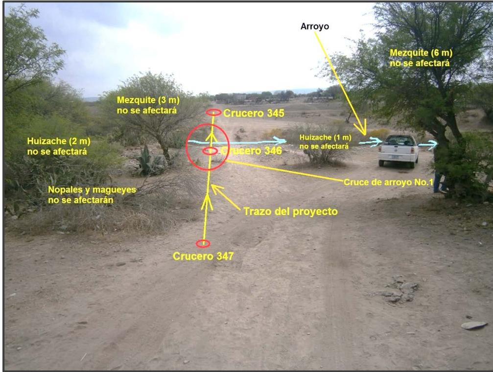
En la imagen, se observa la dirección del trazo del proyecto y el cruce de arroyo No. 1 comprendido en el tramo entre los cruceros 347, 346 y 345; donde, en dicha zona, no se afectará ningún tipo de vegetación, proyectada la tubería por camino de terracería existente.
