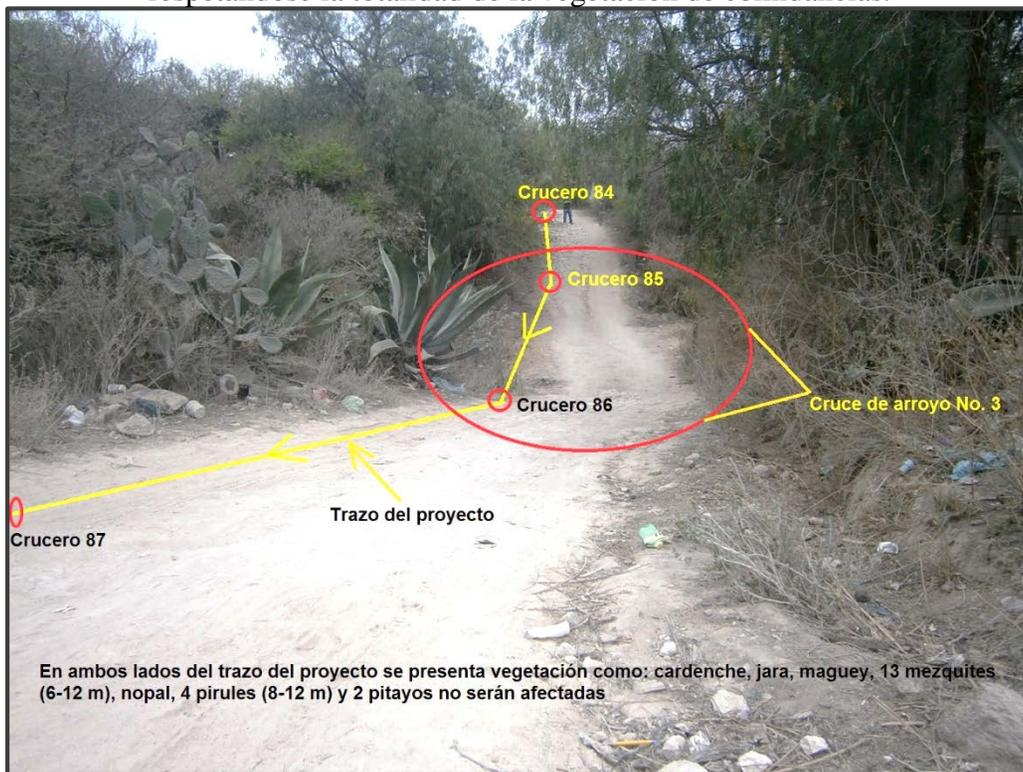
En la imagen, se observa la dirección del trazo del proyecto y el cruce de arroyo No. 3; donde no se afectará ningún tipo de vegetación. La tubería irá tendida en forma subterránea por camino de terracería existente.
