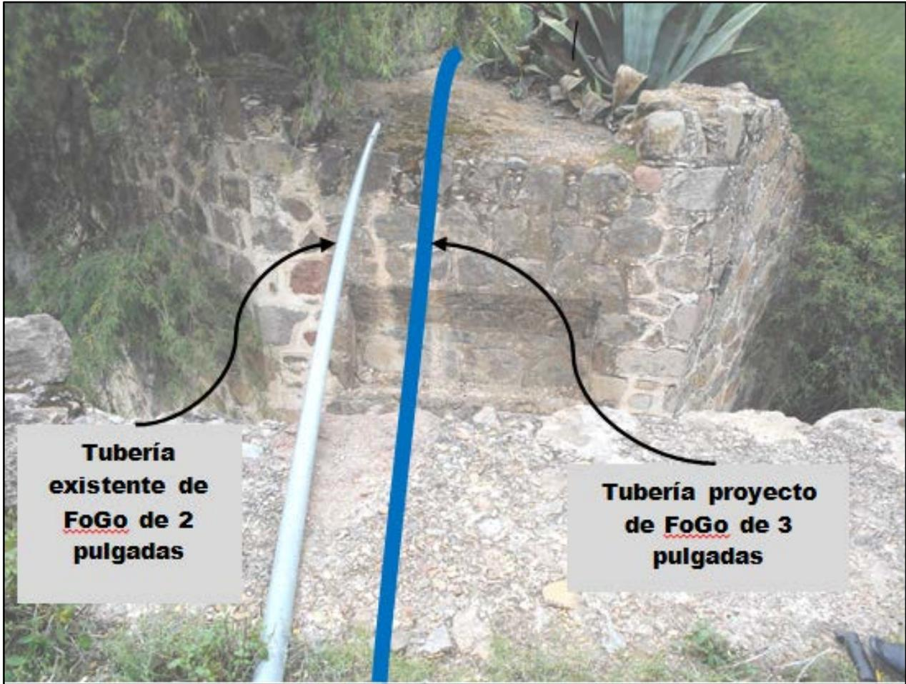
Imagen donde se observa el cruce 4 de arroyo aéreo que se realizará apoyado en pilastras de mampostería existentes
