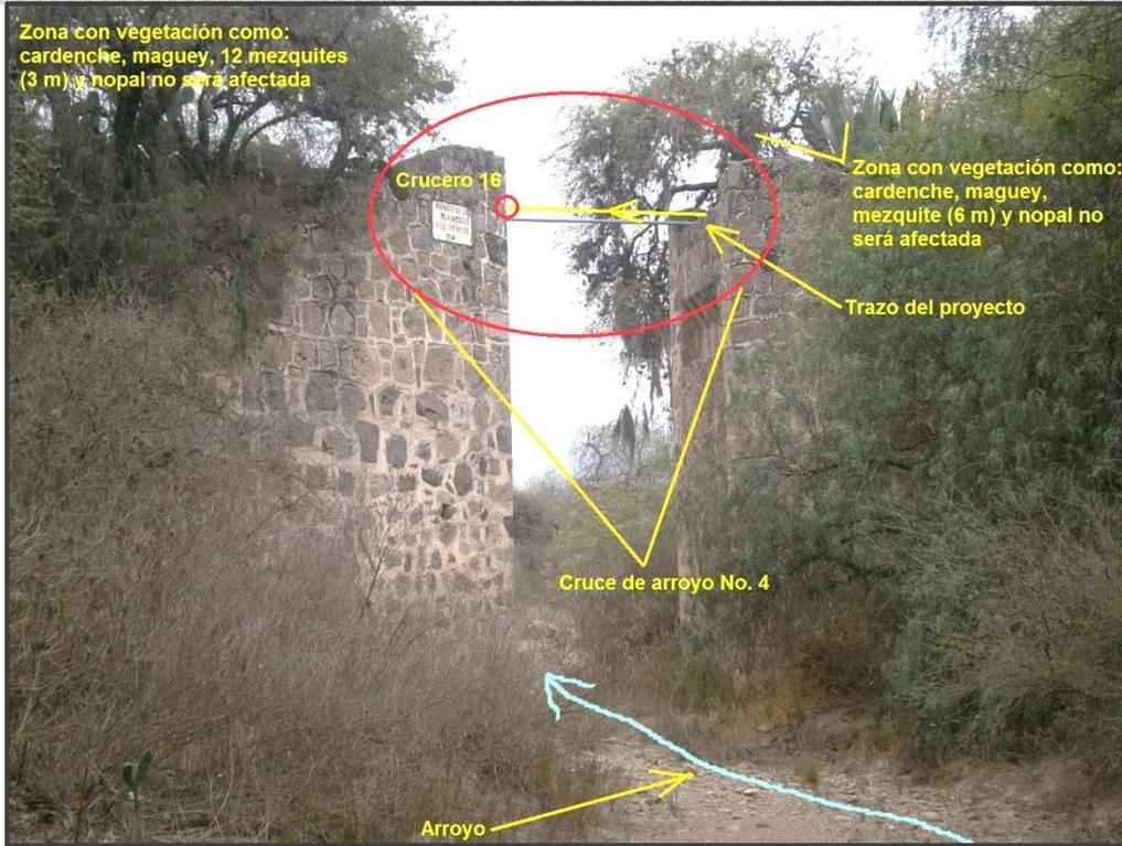
En la imagen, se observa la dirección del trazo del proyecto y el cruce de arroyo No. 4 entre los cruceros 15 y 16; donde no se afectará ningún tipo de vegetación. La tubería irá en forma aérea en el punto de cruce.
