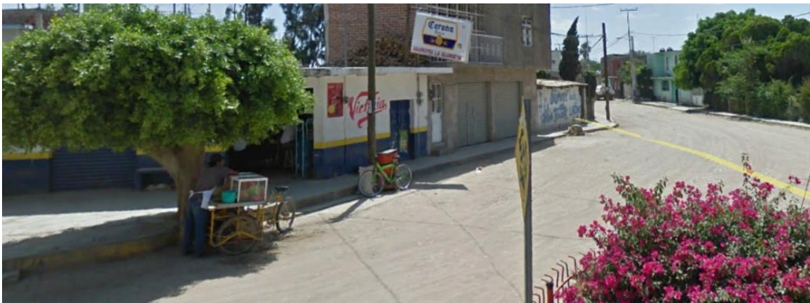
Figura 38 Aspecto general de la zona catalogada por INEGI como Urbano Construido
