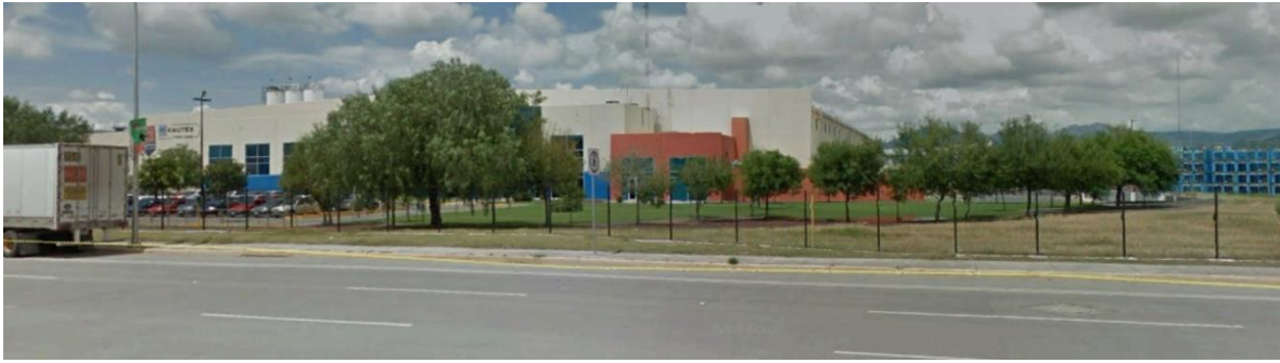
Figura 37 Aspecto general de la zona catalogada por INEGI como Urbano Construido, es dentro del Parque Puerto Interior
