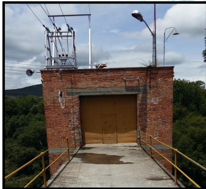
Imagen 20. Vista de la subestación actual
