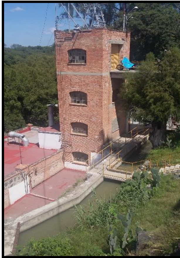
Imagen 16. Vista exterior de casa de máquinas
