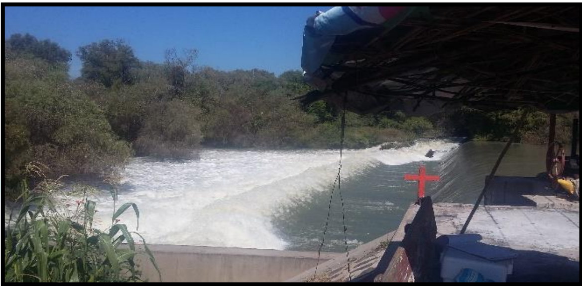
Imagen 3. Presa Derivadora San Juan
