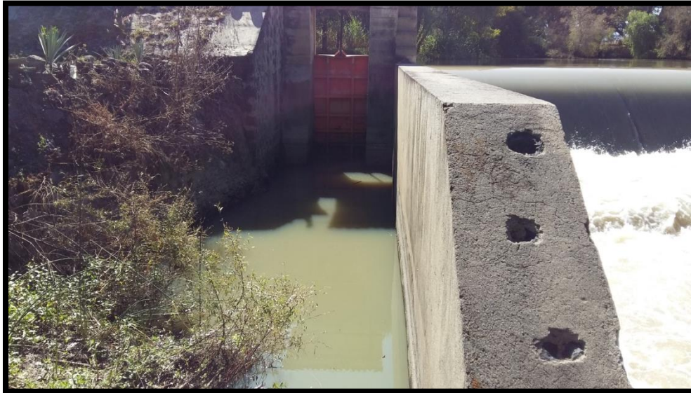
Imagen 25. Vista desde aguas abajo hacia aguas arriba, canal desarenador
