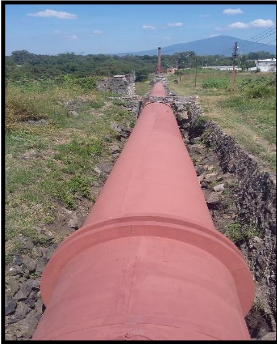
Imagen 12. Tubería forzada
