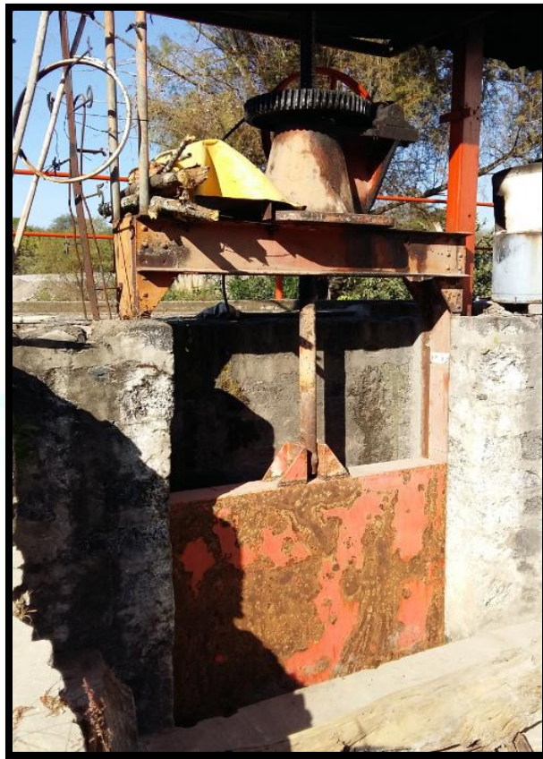
Imagen 26. Compuerta, vástago y engrane en obra de toma
