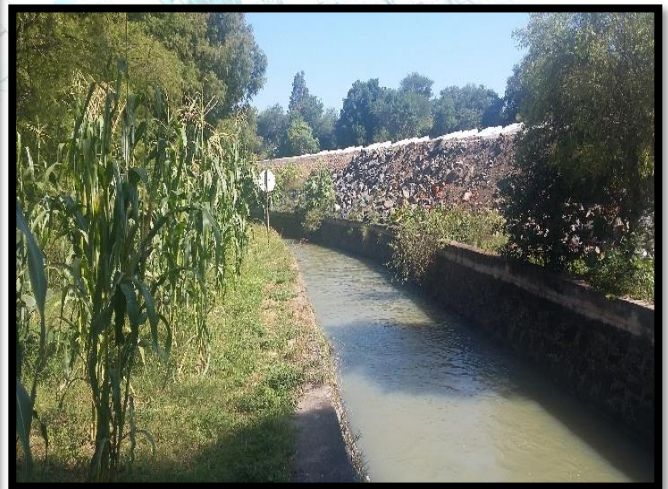
Imagen 7. Vista del canal Reforma
