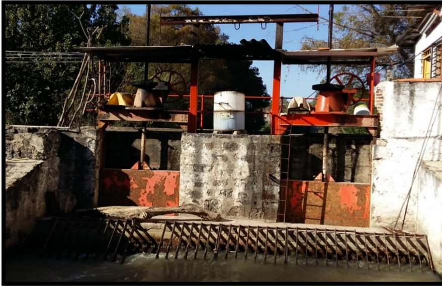
Imagen 27. Corrosión en compuertas de obra de toma
