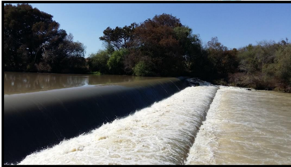
Imagen 23. Sección de cortina con cubeta deflectora
