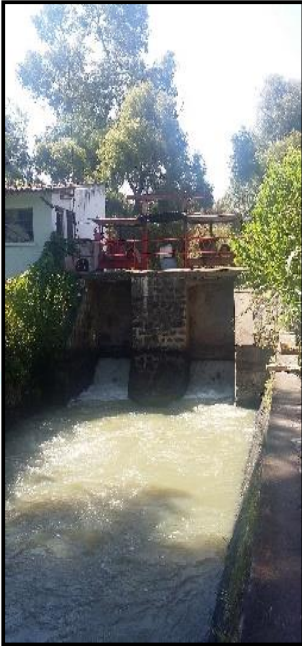
Imagen 6. Obra de toma del Canal Reforma
