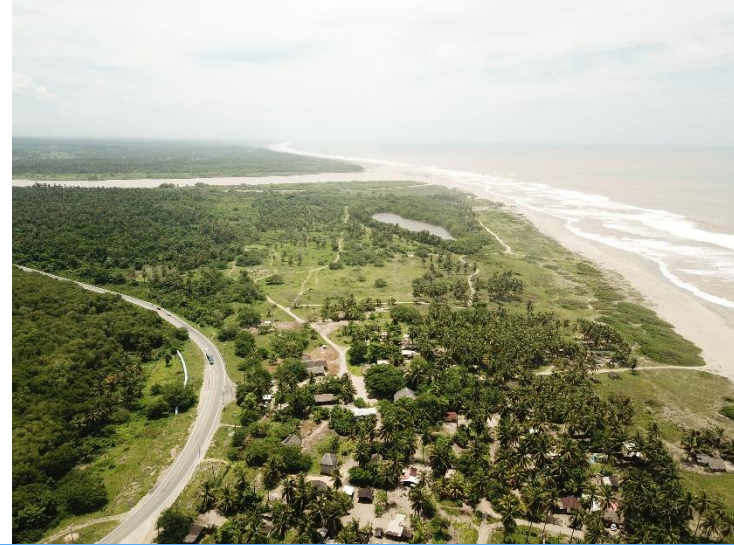
Carretera pavimentada Acapulco-Pinotepa.
