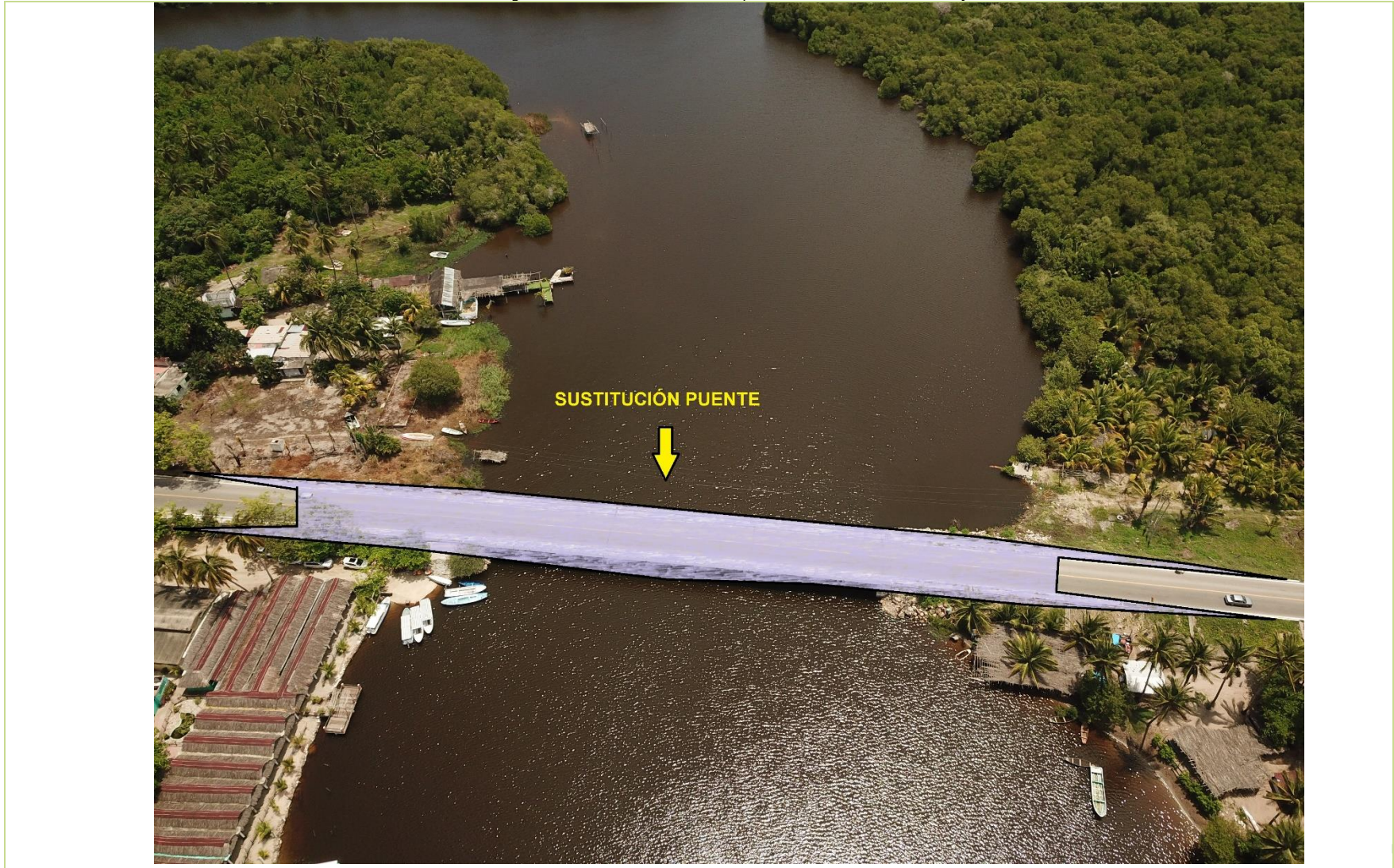
Fotografía VII. 2. Sustitución del puente existente "Barra Vieja".
