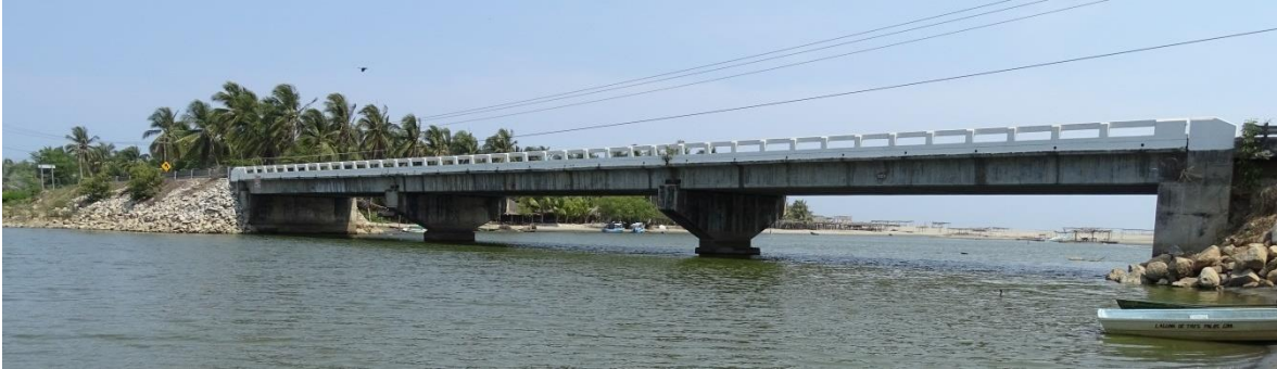
Imagen I. 1. Vista del puente existente
