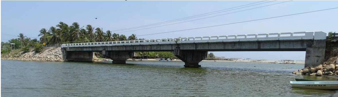
Imagen I. 4. Vista del puente existente
