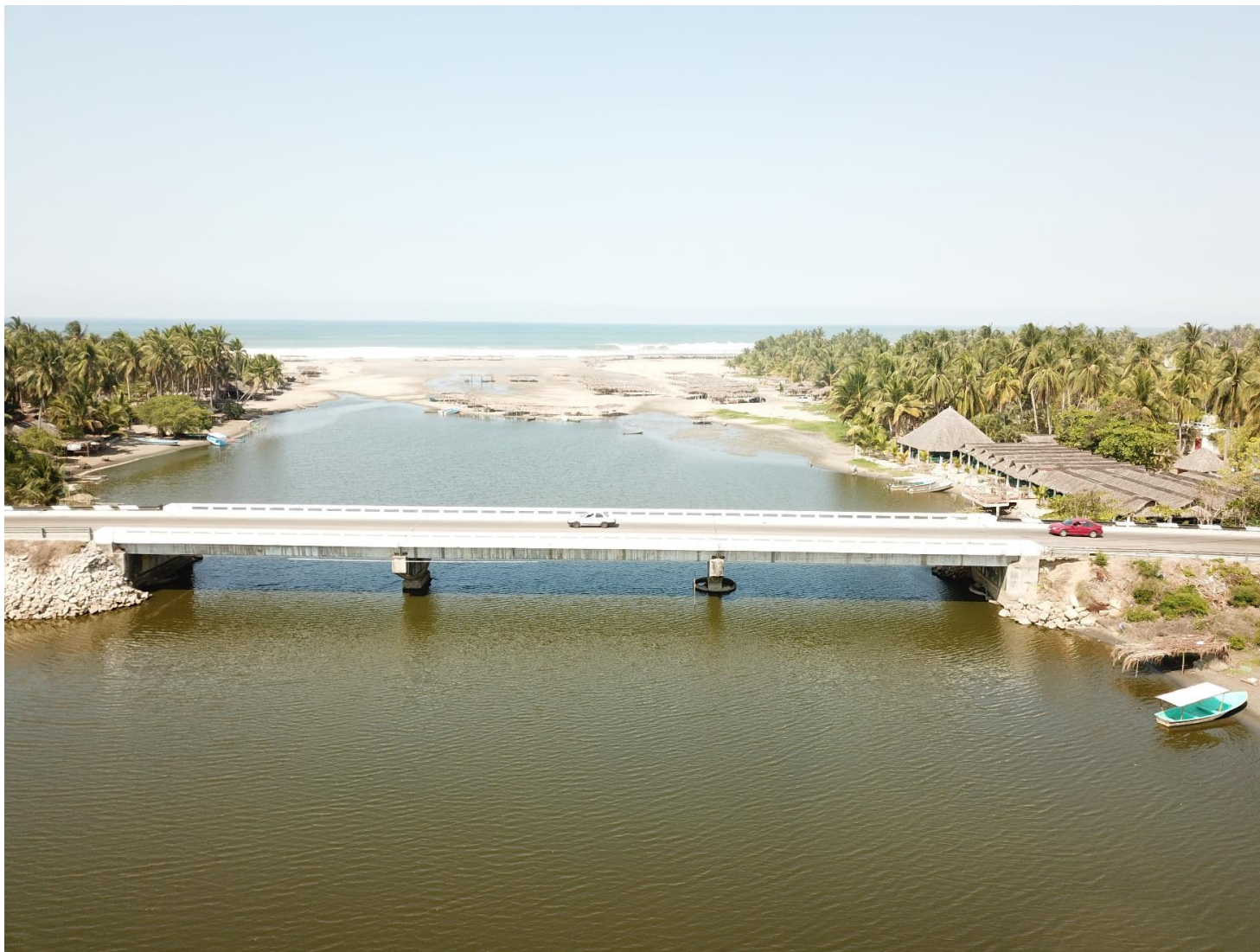
Imagen II. 7 Vista aérea del puente existente y en operación
