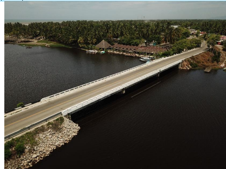
Carretera pavimentada Acapulco-Pinotepa
