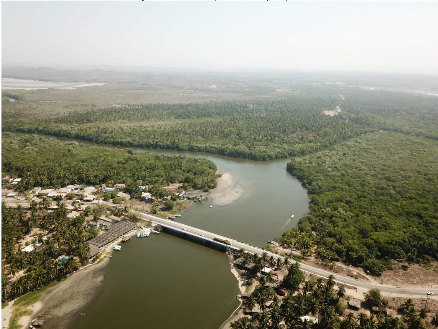
Imagen II. 6 Vista aérea del puente existente y en operación
