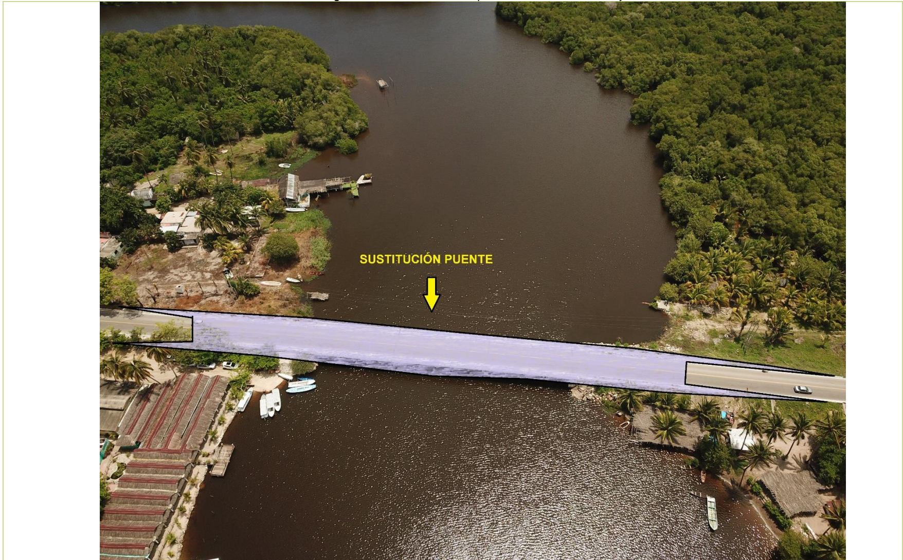
Fotografía V. 4. Sustitución del puente existente "Barra Vieja".
