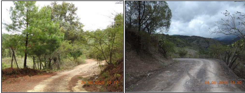
Figura II.20 Vista del camino existente y el cual será utilizado para llegar al frente de obra.
