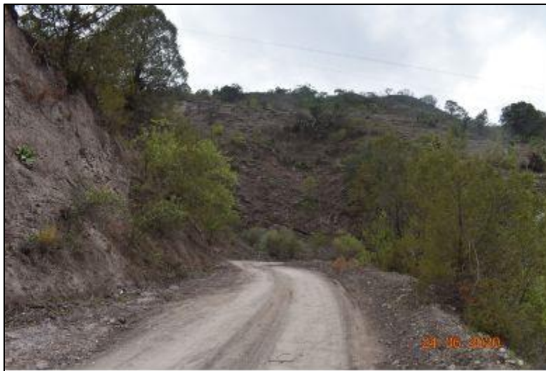
Figura II.16 Vista del camino que pertenece a la localidad de Yextla.
