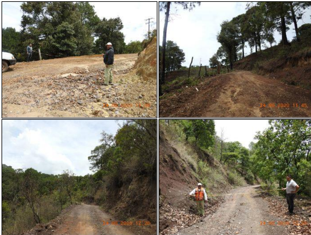
Figura II.9 Vista de las condiciones del subtramo Viento Frio – Izotepec donde se observa, que en algunas zonas se requiere de la ampliación del actual camino para cumplir con el ancho de corona de 7.0 metros.
