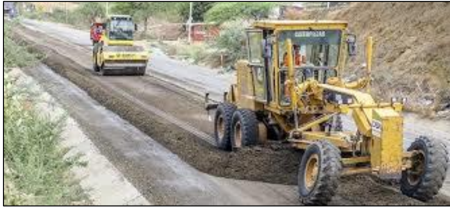
Figura V.6 Ejemplo de las actividades de construcción de un avía de comunicación similar
