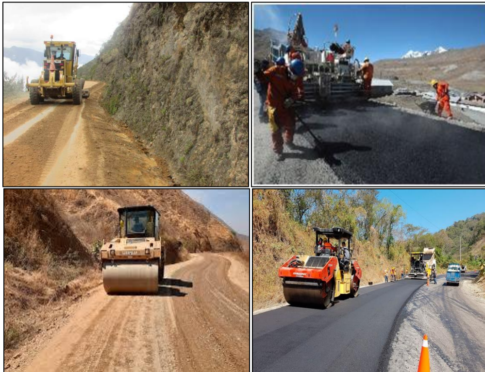
Figura II.28 Ejemplo de la construcción de un camino tipo D.
