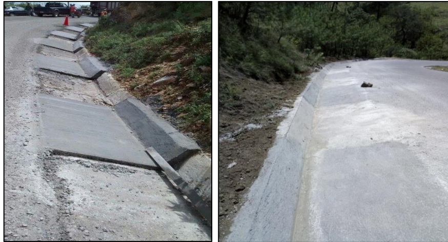
Figura V.9 Ejemplo de construcción de obras de drenaje menor (cunetas).
