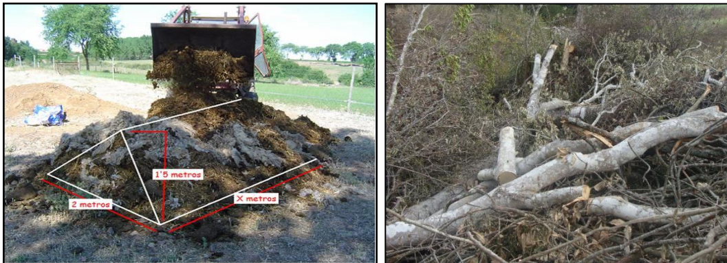
Figura V.7 Ejemplo del amontonamiento del suelo natural resultado del despalle
