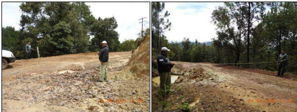
Figura I.1 Vista de las condiciones actuales del camino que pretende modernizarse.
