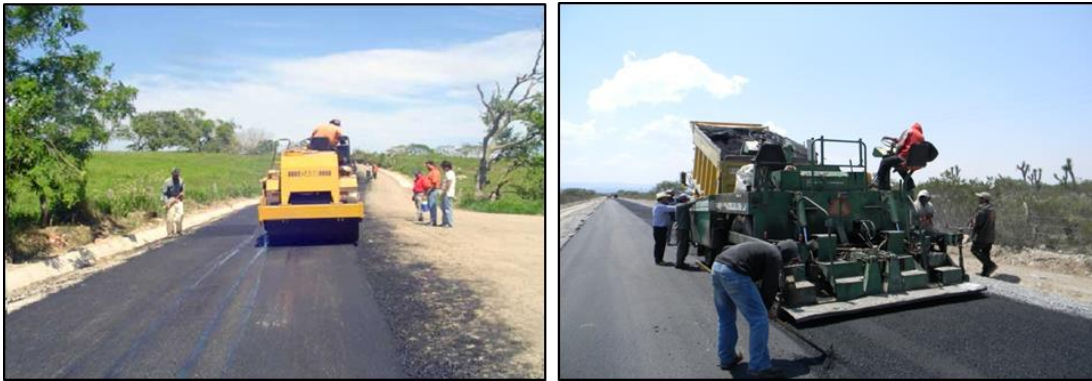
Figura II.23 Ejemplo del encarpado asfáltico de un proyecto similar.
