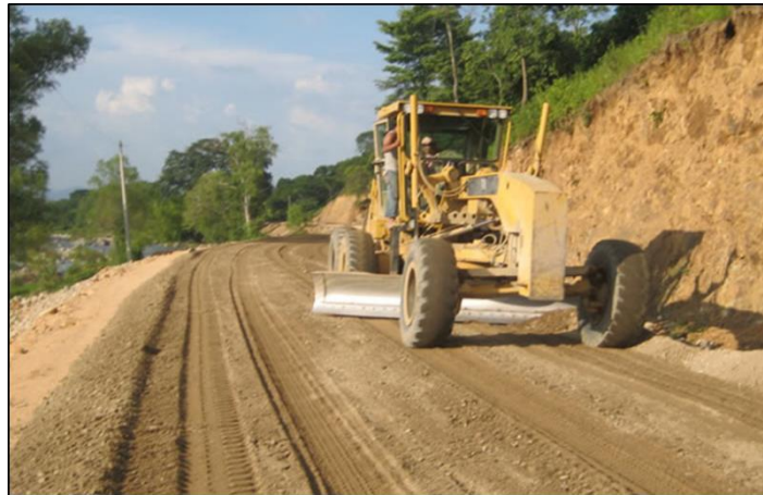
Figura V.5 Ejemplo de la nivelación del terreno en una obra similar.
