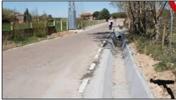
Figura V.11 Ejemplo de una obra de drenaje menor.
