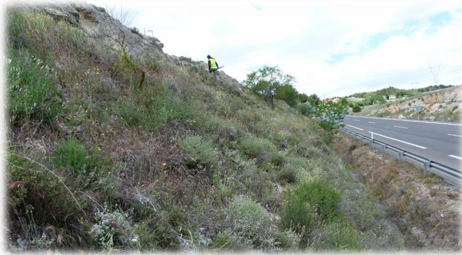
Imagen VI. 13. Ejemplo de arropo de talud.
