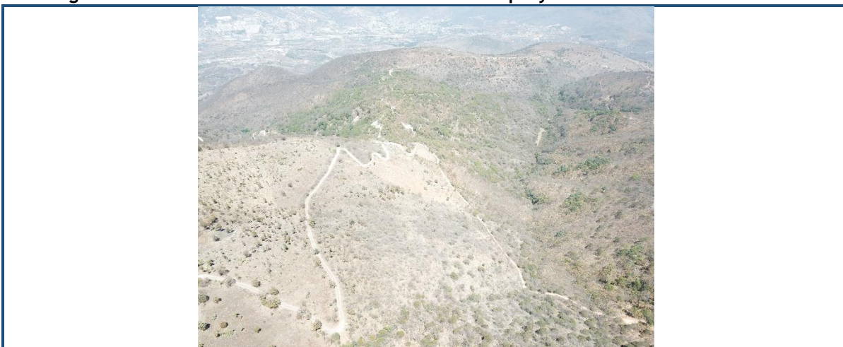
Fotografía IV. 14. Aérea donde existirá afectación del proyecto del 9+000 al km 10+000
