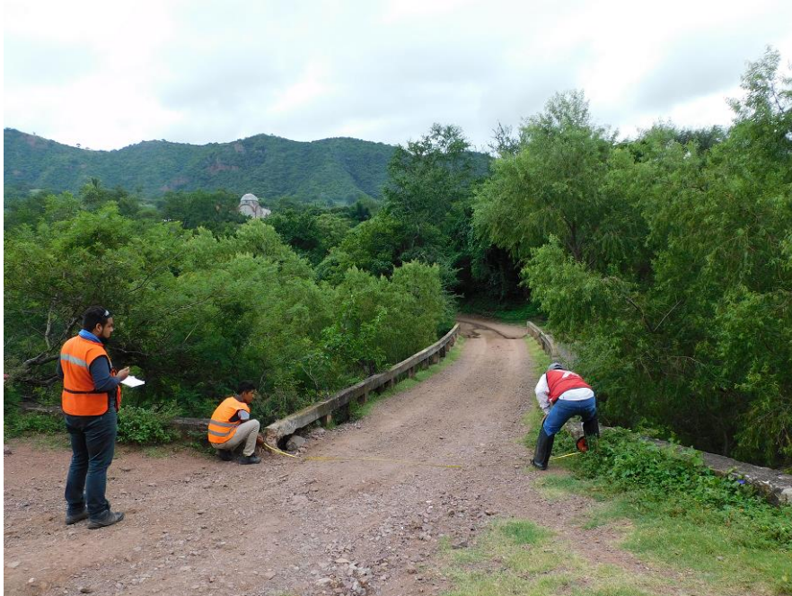
Figura 12. Condiciones del puente actual.
