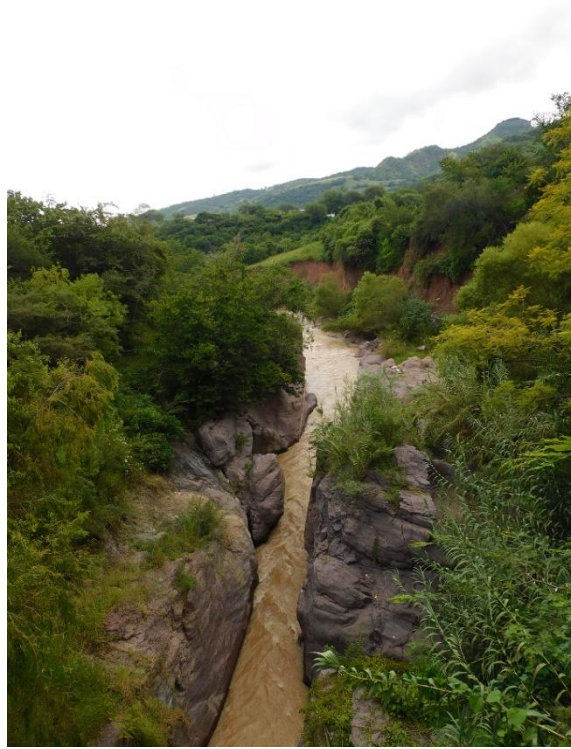
Figura 11. Condiciones del escurrimiento en el que se construirá el Puente.
