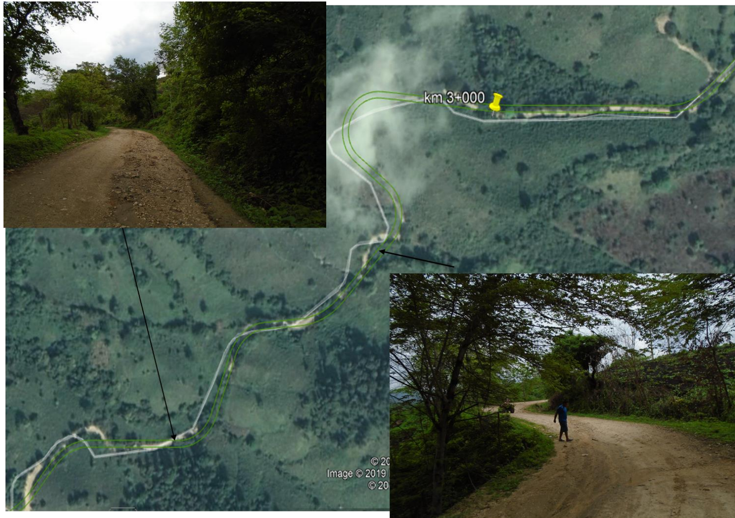
Ilustracion. 84. -Imagen satelital del tramo a pavimentar con imágenes del km 2+000 al km 3+000
