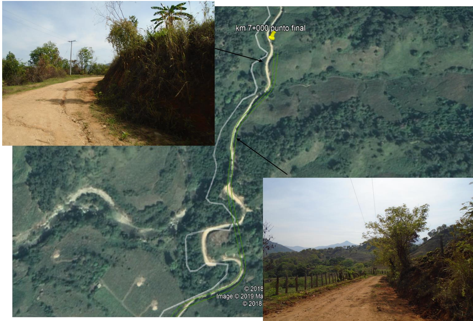
Ilustracion. 89.- Imagen satelital del tramo a pavimentar con imágenes del km 6+500 al km 7+000
