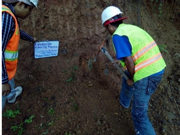
Ilustración 8.- Ejecución de canal para la toma de muestra
