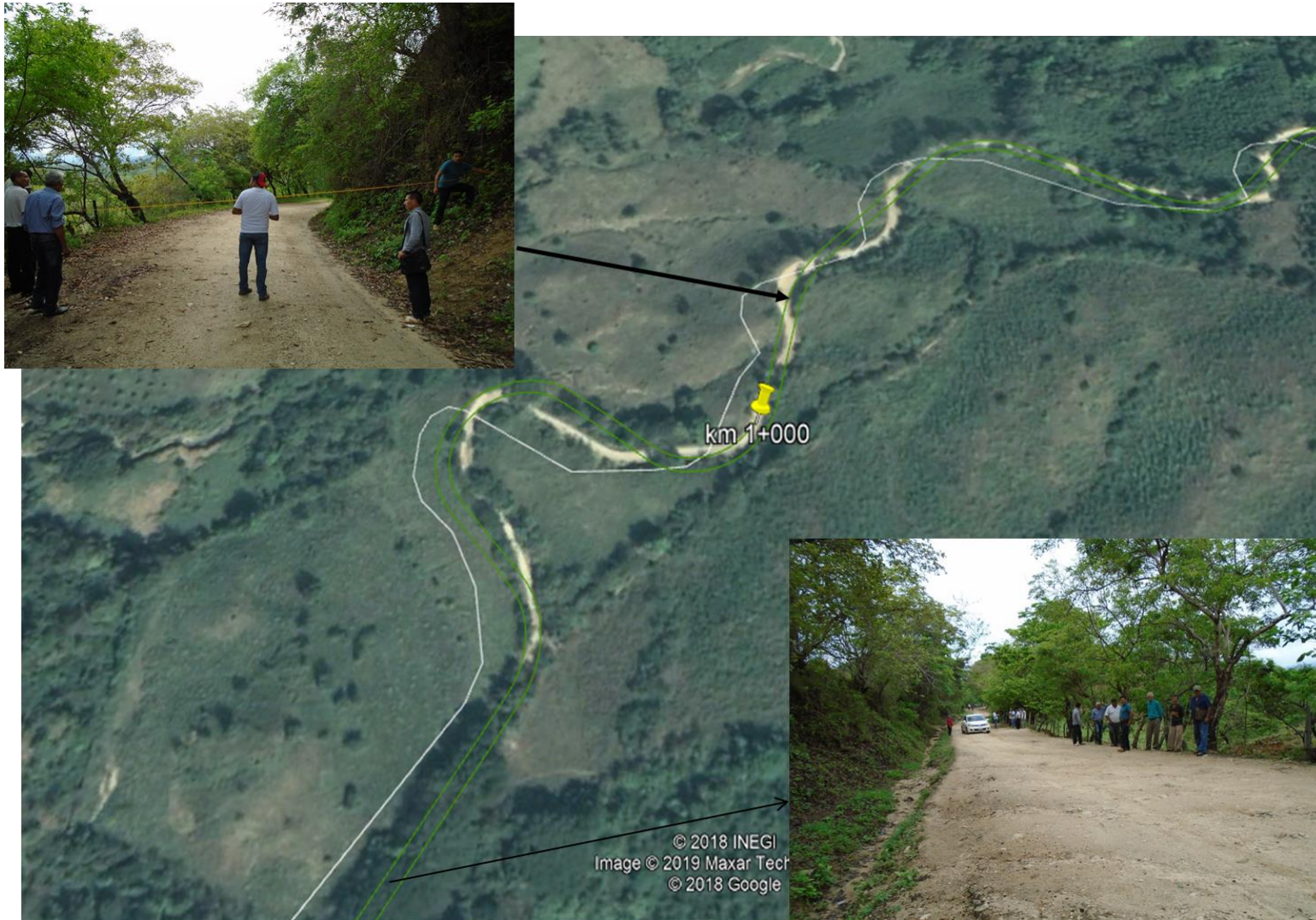
Ilustracion. 82.- Imagen satelital del tramo a pavimentar con imágenes del km 0+500 al km 1+200.
