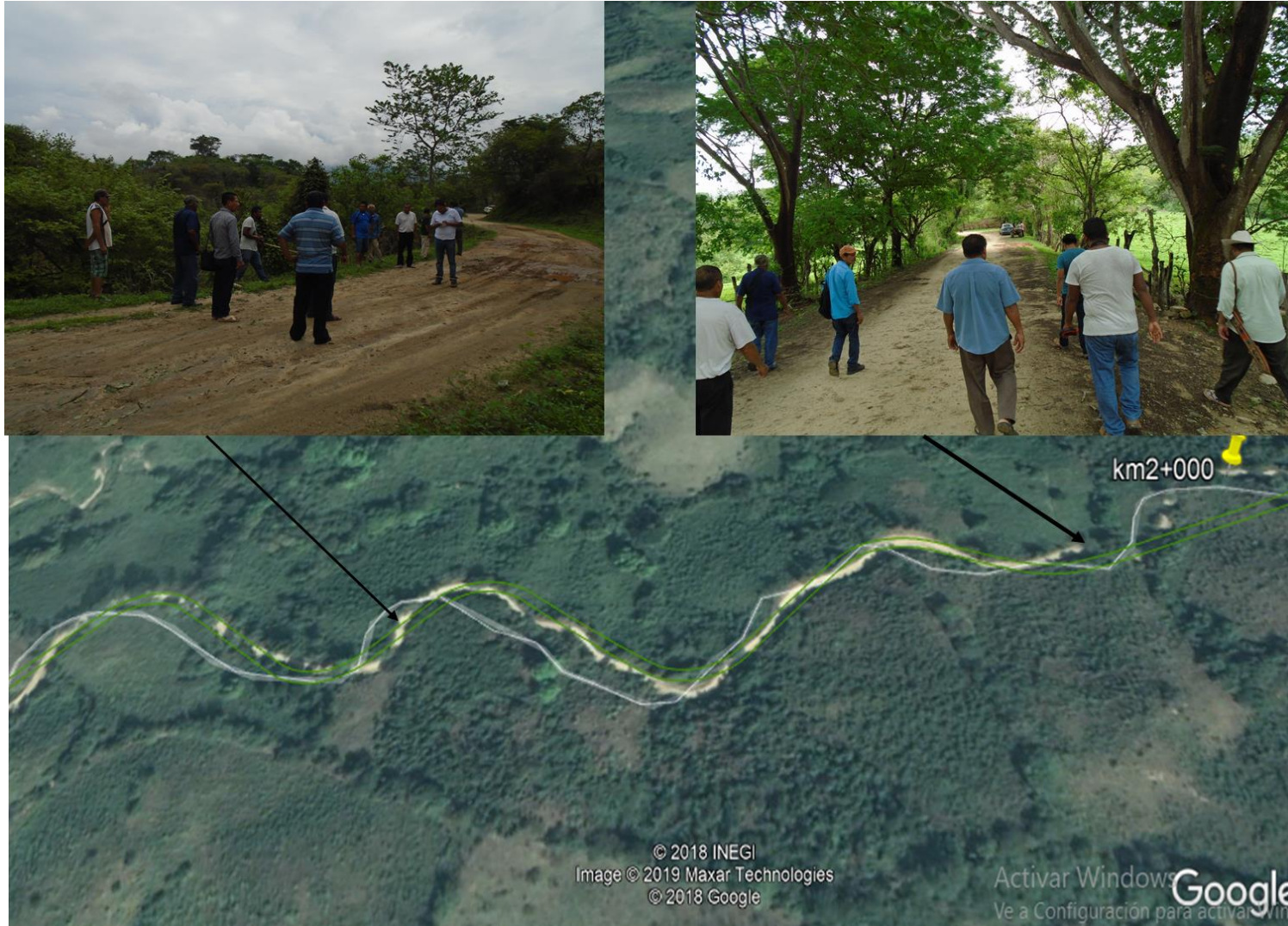
Ilustracion. 83. -Imagen satelital del tramo a pavimentar con imágenes del km 1+200 al km 2+000
