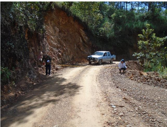
Medición del ancho del camino actual 7.7 m.
