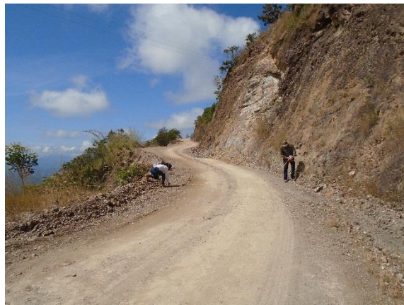
Medición del camino y toma de datos. 7 m. de ancho del camino actual con Pastizal Inducido y Vegetación Secundaria Arbustiva.
