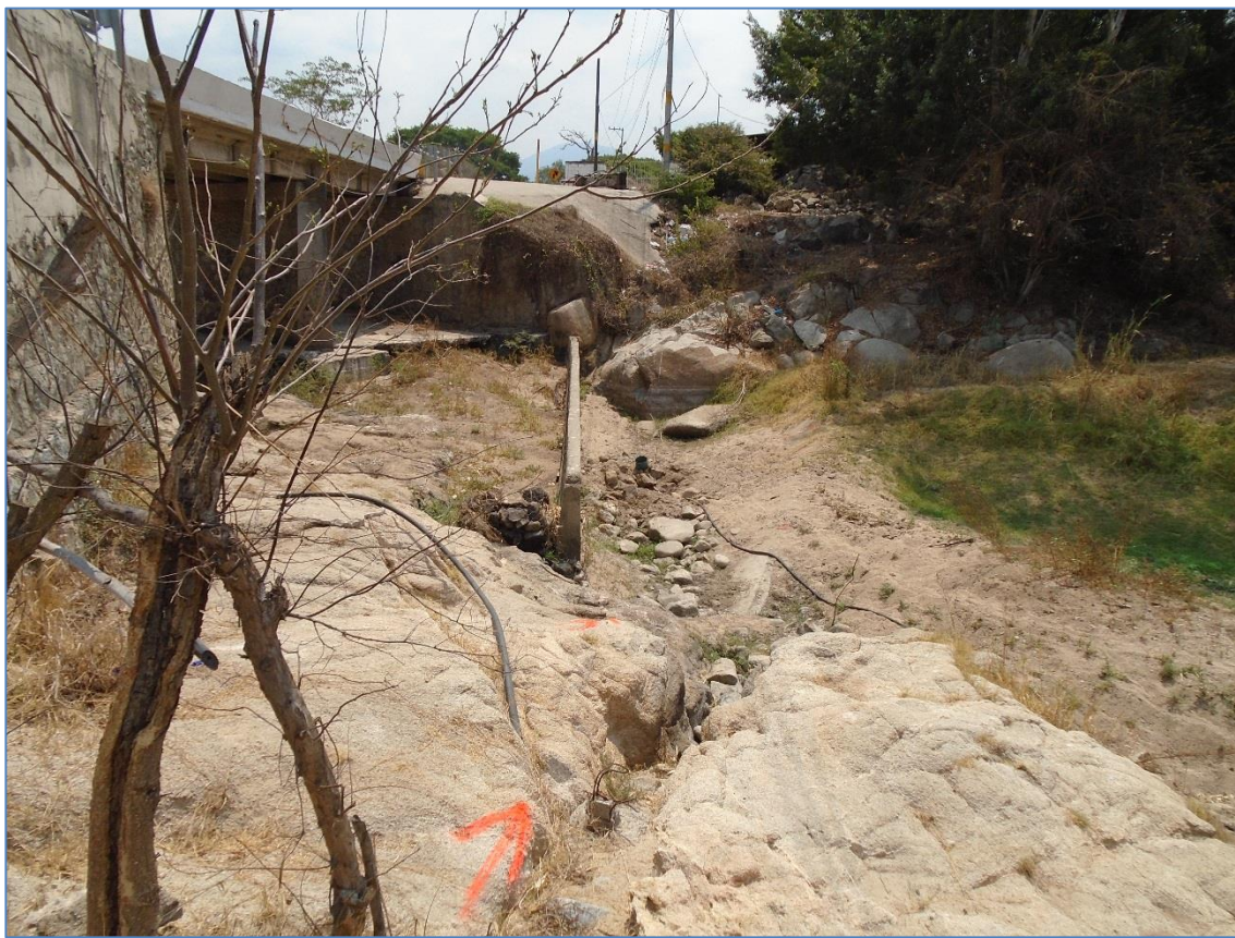
Figura 68. Estado actual del cauce del arroyo, adyacente a la actual vía de comunicación, punto donde se reconstruirá el puente.
