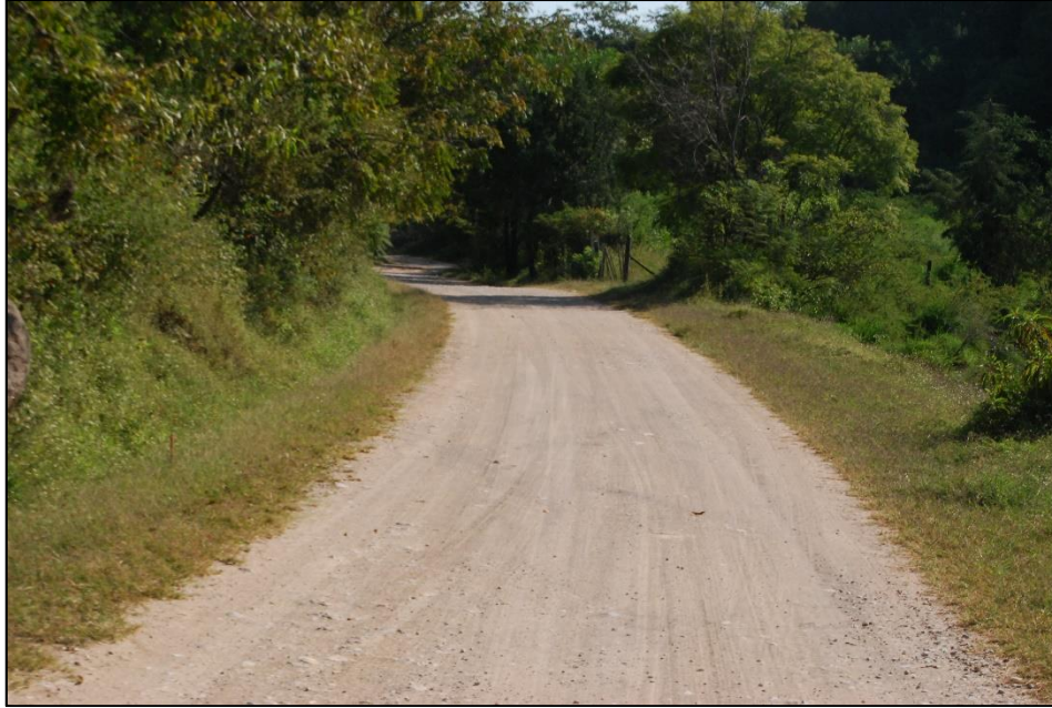
Ilustración 19. Escenario sin la ejecución del Proyecto de pavimentación carretera, Km. 0+000
