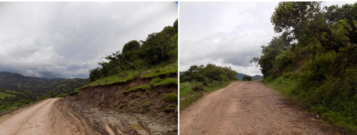
Ilustración 35. Final del tramo carretero, Km. 25+000
