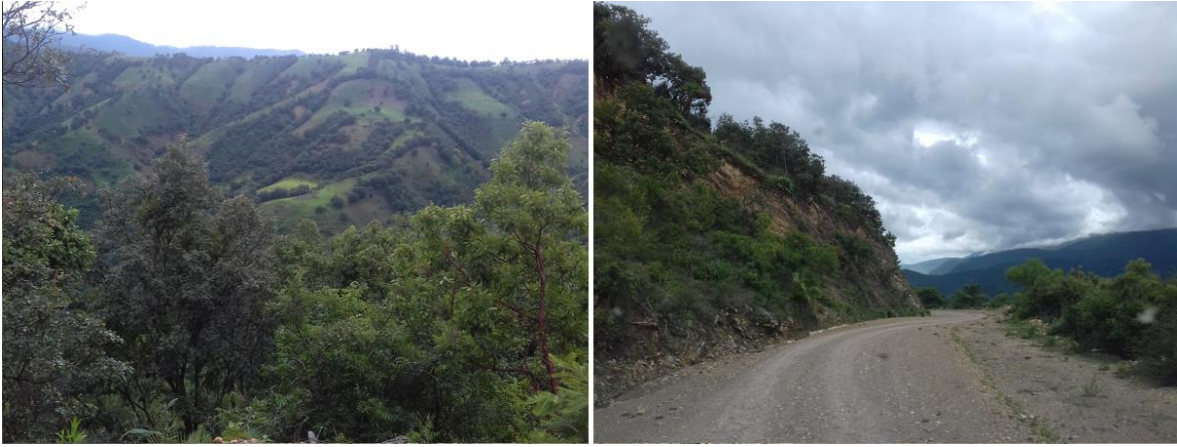
Ilustración 22. Condiciones actuales del tramo carretero, Km. 0+750
