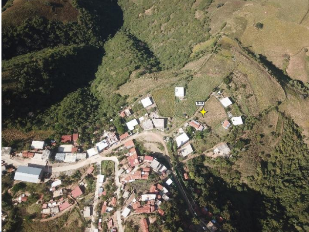
Obra de drenaje 23.
