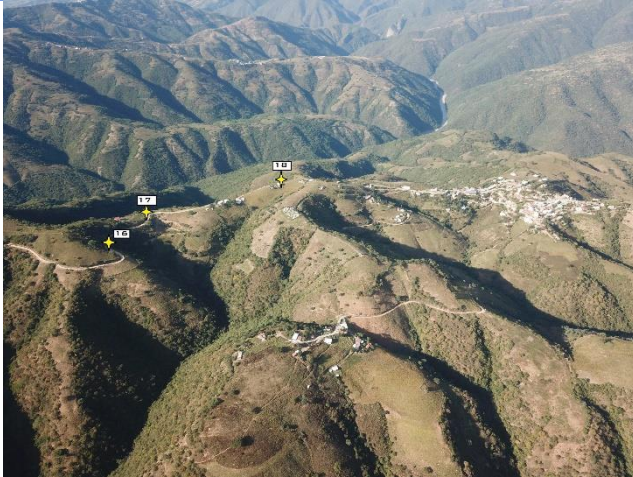
Vista superior desde dron de las obras de drenaje 16 a la 18.
