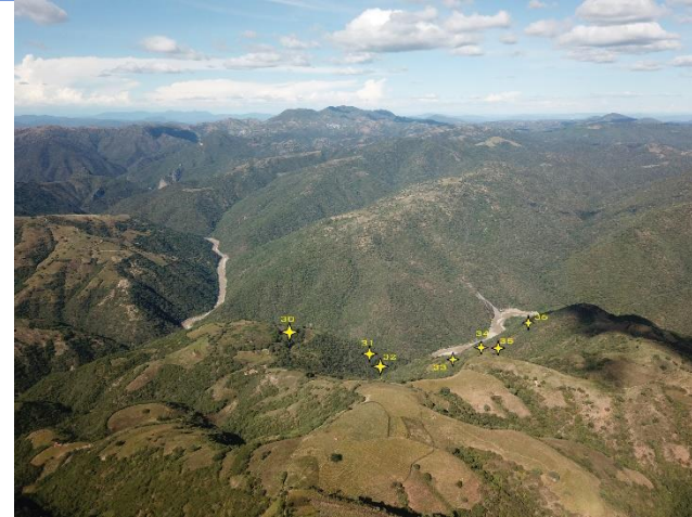
Vista superior desde dron de la obra de drenaje 30-36.
