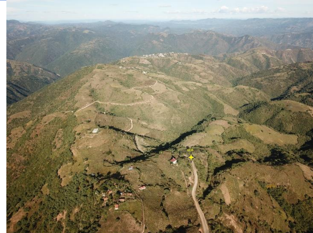
Vista superior desde dron de la obra de drenaje 04.
