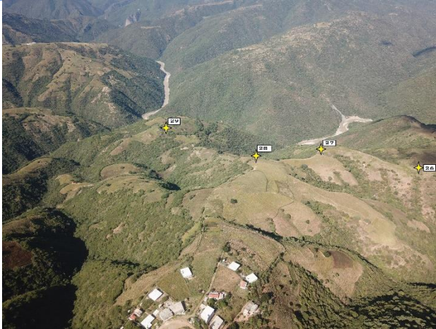
Vista superior desde dron de la obra de drenaje 26 a la 29.
