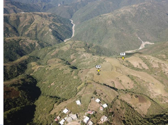
Vista superior desde dron de las obras de drenaje 24 y 25.
