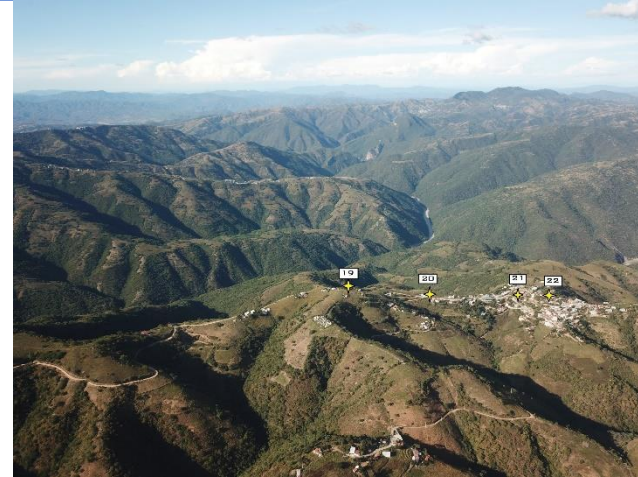
Vista superior desde dron de las obras de drenaje 19 a la 22.
