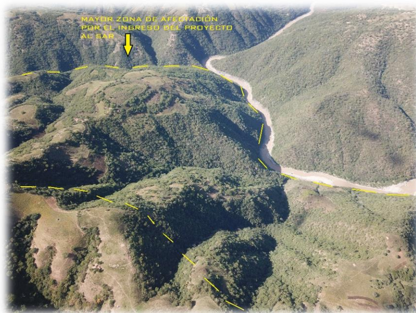
Fotografía V. 3. Zona de mayor afectación una vez ingresado el trazo.
