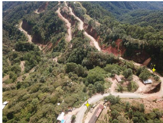
Vista superior desde dron de las obras de drenaje 11 y 12.
