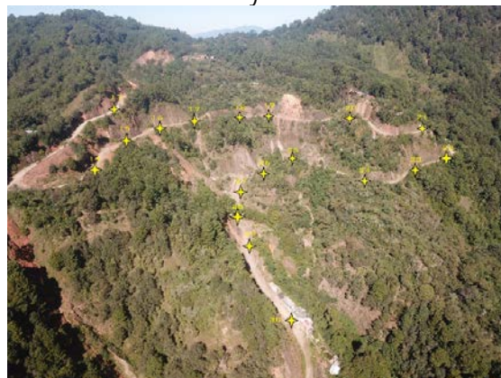
Vista superior desde dron de las obras de drenaje 13 a la 30.
