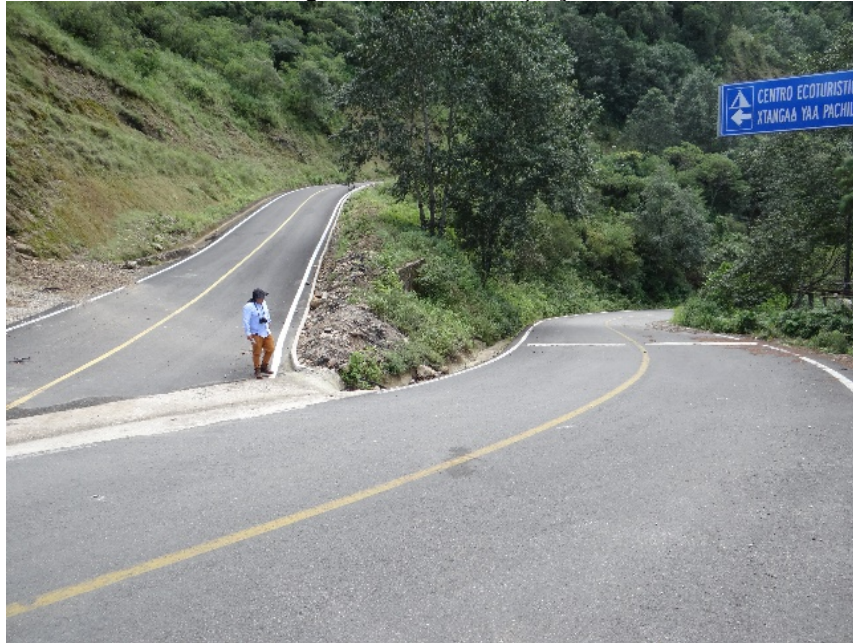
Fotografía I. 1. Inicio del proyecto
