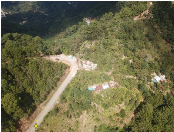
Vista superior desde dron de la obra de drenaje 10.
