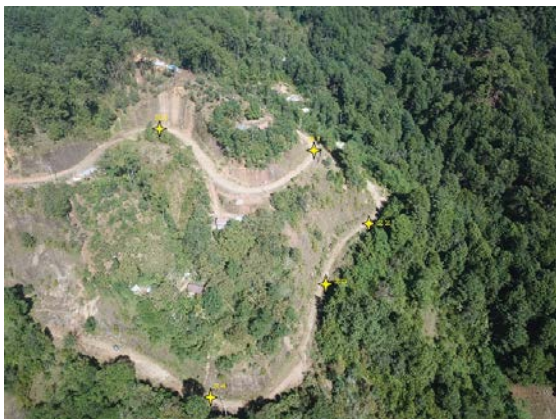
Vista superior desde dron de las obras de drenaje 20 a la 24.
