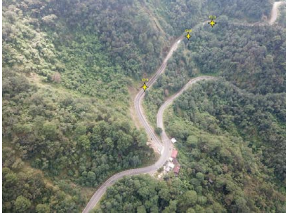
Vista superior desde dron de las obras de drenaje 01 a la 03.
