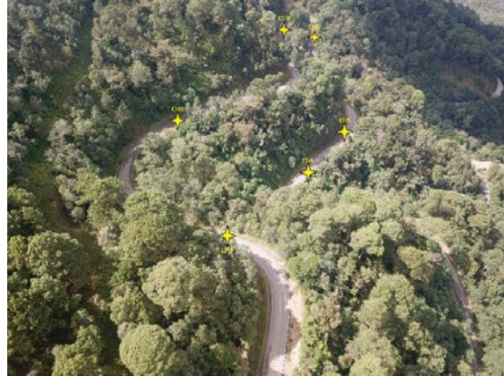
Vista superior desde dron de las obras de drenaje 04 a la 09.
