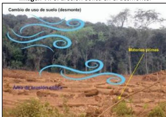
Imagen VI. 6. Erosión eólica en el desmonte.
