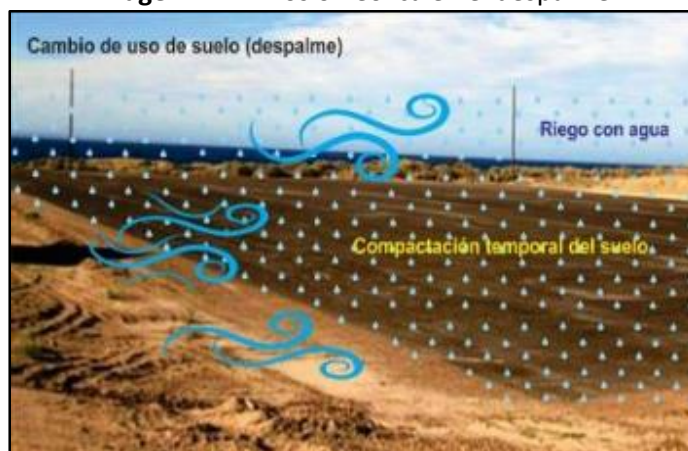
Imagen VI. 7. Erosión eólica en el despalme.
