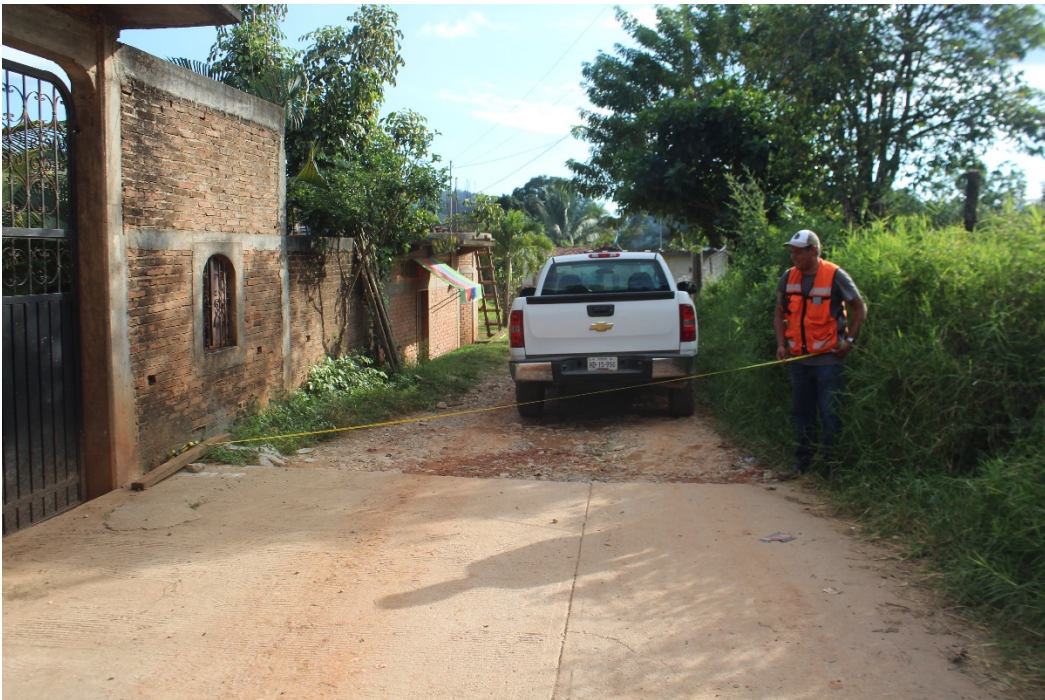
Tramo final del camino a modernizar en la localidad del Carmen
