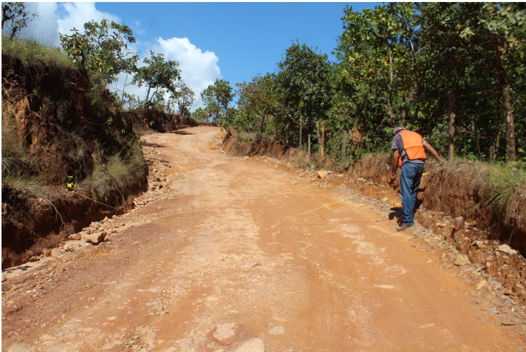
Medición del ancho del camino a modernizar
