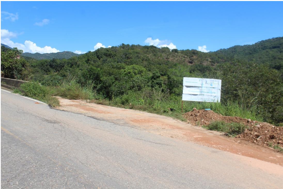
Inicio del tramo a modernizar
