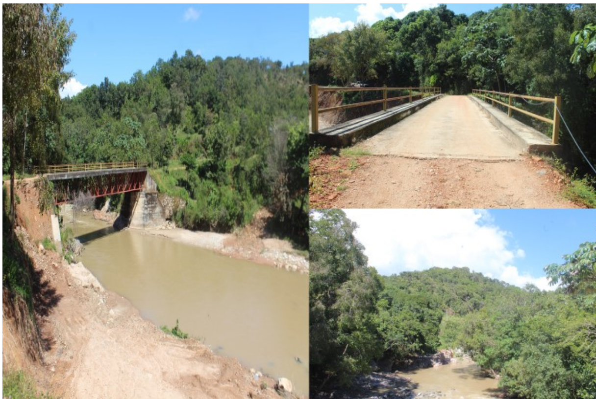
Figura 14. Rio san Pedro presente en el SAR, dentro del cruce del camino presenta un puente
