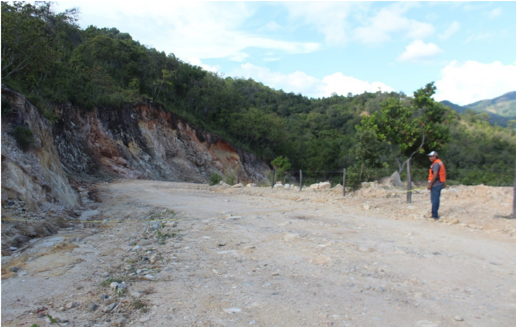
Medición de los anchos del camino a modernizar
