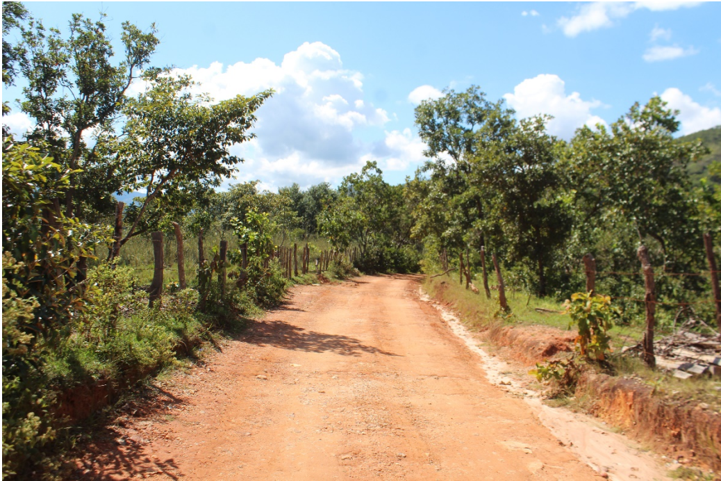
Camino a modernizar se observa a lo largo del camino vegetación secundaria arbórea de bosque de encino
