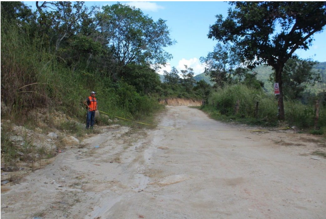
Medición de los anchos del camino a modernizar
