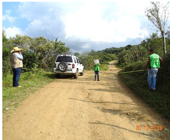
Fotografía 15. Medición de la línea de ceros del camino
