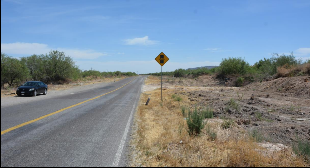
Figura No. 37 Carretera, fotografía tomada en dirección Sur a la Población de Bermejillo, Durango.
