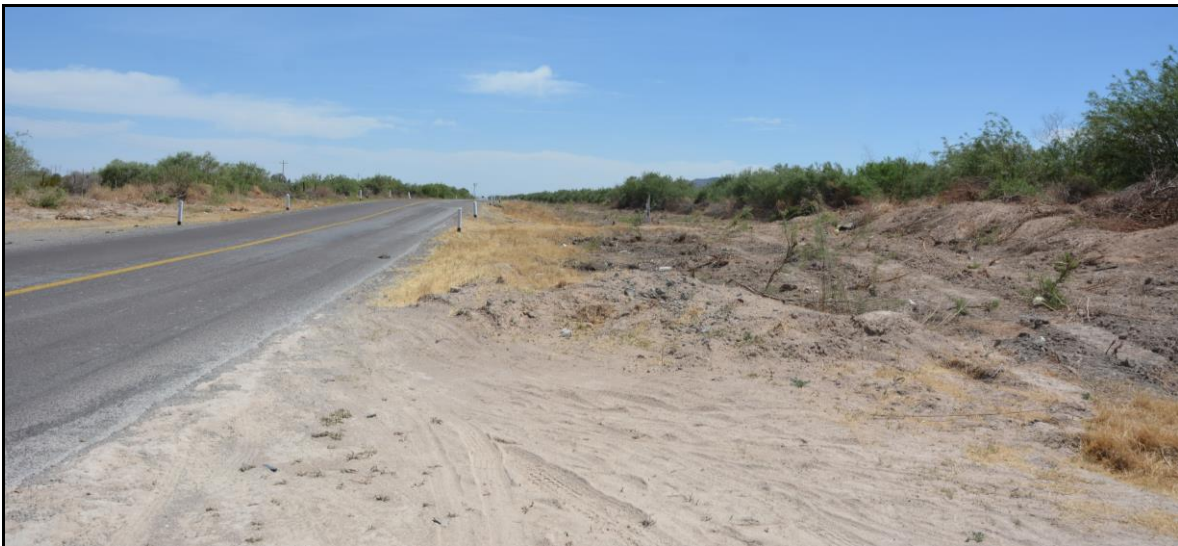
Figura No. 18 Vista Sur del derecho de vía. Lado Oeste del derecho de vía.
