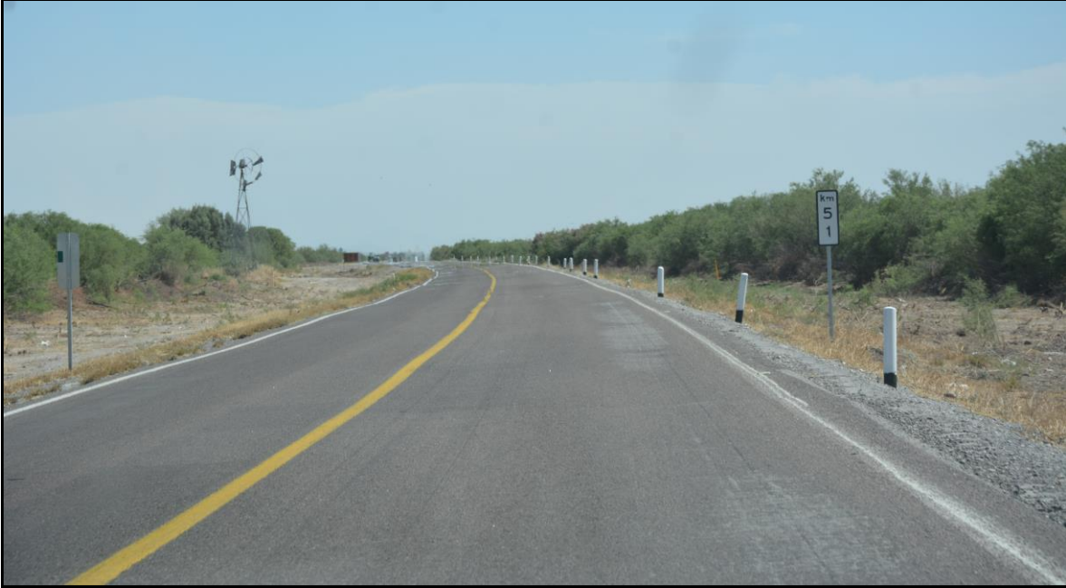
Figura No. 14 La carretera que accede al sitio del actual vado se encuentra pavimentada y es de tipo C, la población Nombre de Dios, se encuentra antes, en dirección Norte a Jiménez, Chihuahua.
