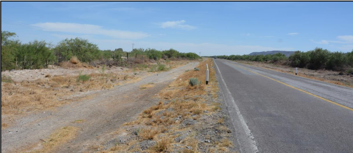
Figura No. 45 El derecho de vía del camino se encuentra libre de vegetación secundaria. Vista en dirección Sur.
