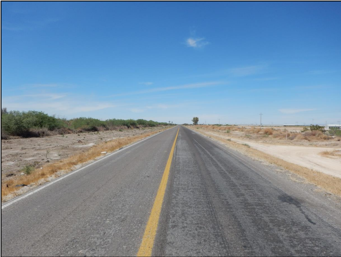
Figura No. 84 Vista Norte del sitio del proyecto y su derecho de vía.
