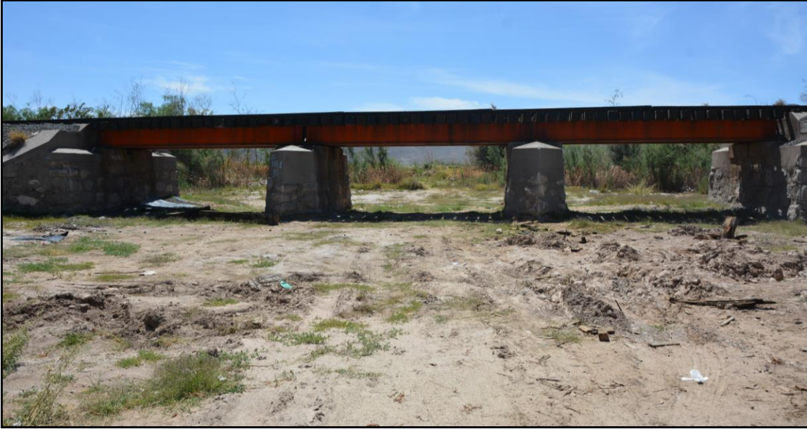
Figura No. 31 Cauce de la escorrentía aguas arriba y puente ferroviario.
