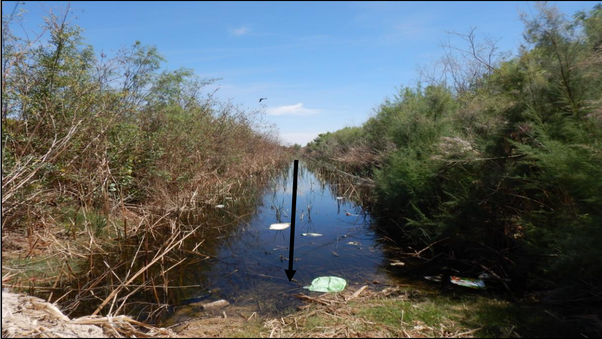
Figura No. 29 Aspecto general del escurrimiento que pasa por debajo del puente del FFCC correspondiente al escurrimiento para el cual se construirá el Puente “Vado”. Época de secas, agua estancada maloliente.
