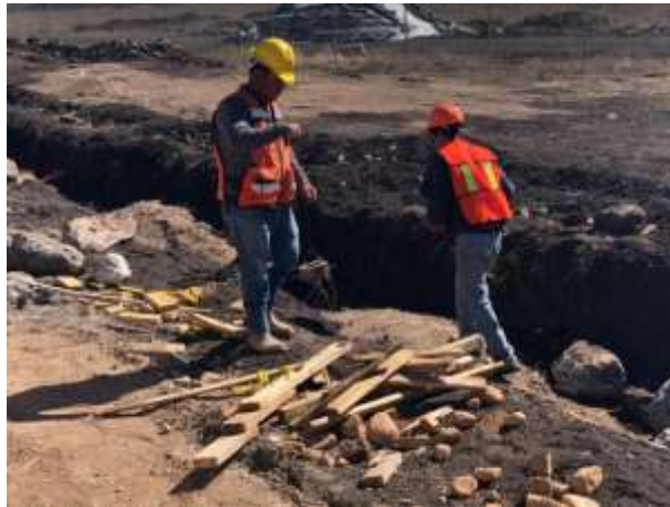
Figura II. 31. Actividades de excavación de zanjas de baja tensión.
