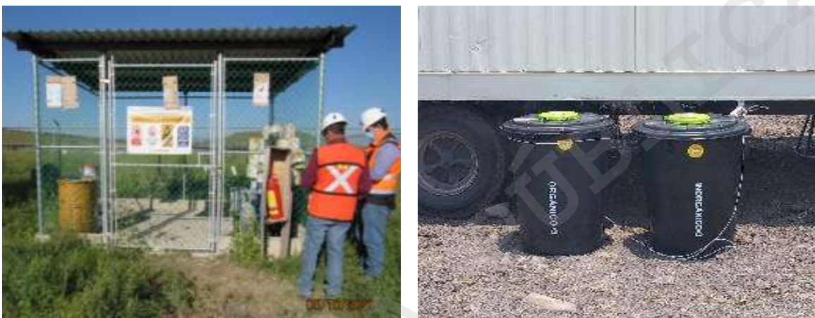
Figura II. 15. Actividades de supervisión ambiental para el cumplimiento del Programa de Vigilancia Ambiental del parque solar y área del proyecto.
