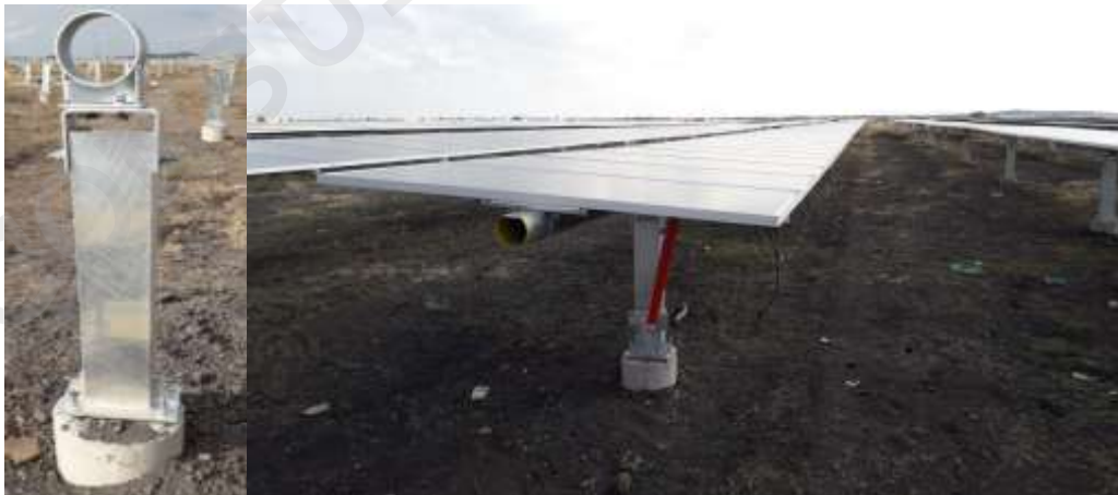
Figura II. 20. Izquierda: micropilote de la estructura de soporte y guía del seguidor. Derecha: línea de paneles instalados.
