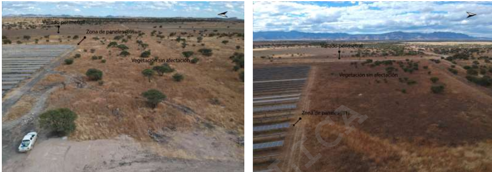
Figura II. 49 Fotografías aéreas del estado actual del parque solar fotovoltaico.
