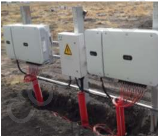
Figura II. 24. Empotramiento de inversor con llegada de cableado proveniente de paneles y conexión para operación y salida de conexiones para transformador.
