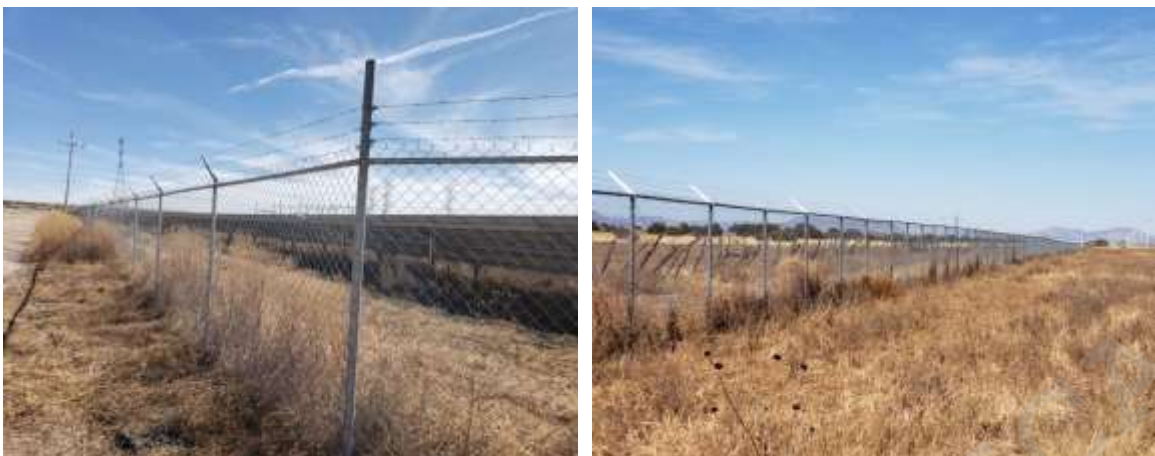
Figura II. 45 Estado actual de la instalación del vallado o cerco perimetral del proyecto.
