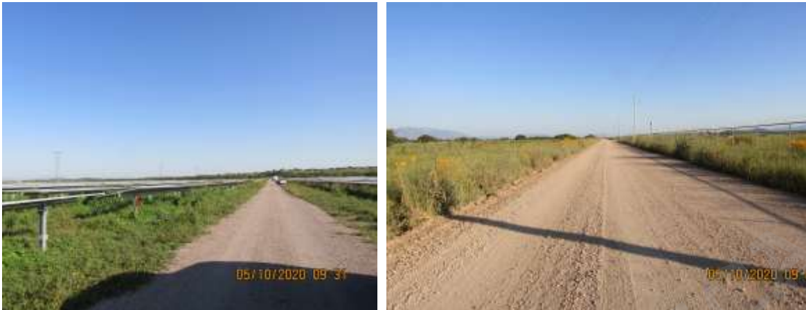
Figura II. 17 Estado actual de los caminos internos del proyecto.
