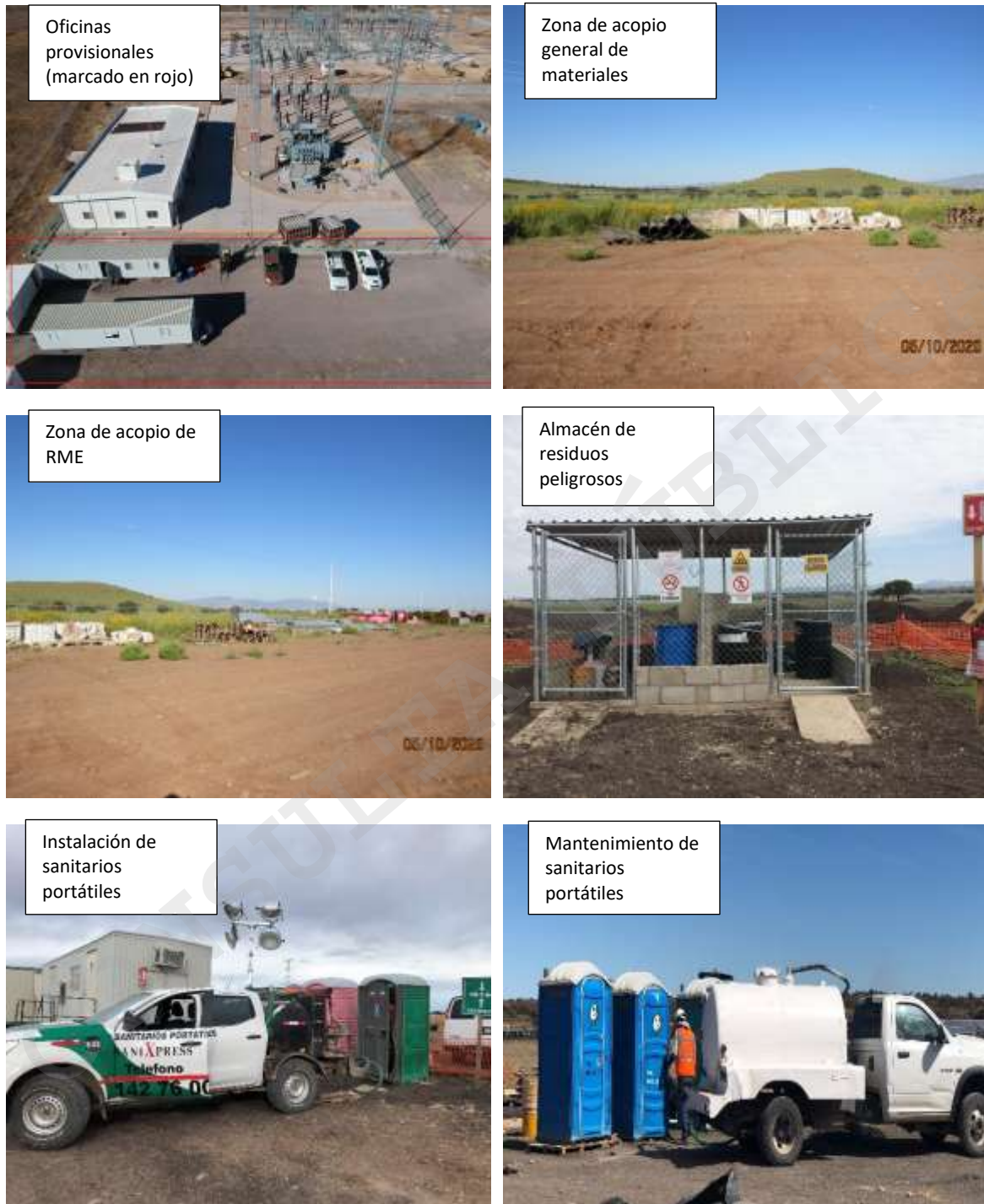
Figura II. 48 Estado actual de las obras provisionales instaladas para el desarrollo del proyecto.
