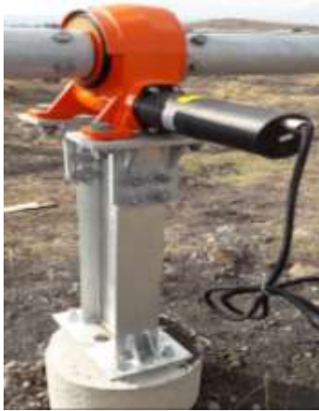
Figura II. 22. Motor de activación.
