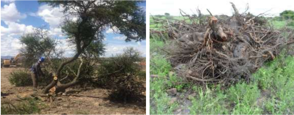
Figura II. 14. Actividades de desmonte y acopio de materiales ejecutadas en el área del proyecto.
