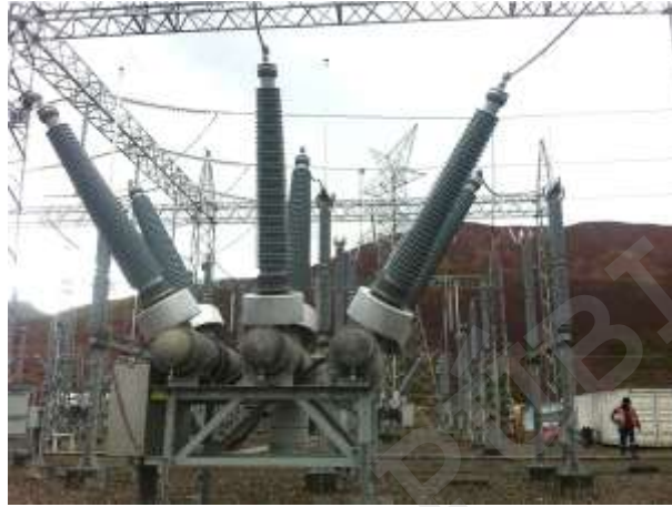
Figura II. 39. Interruptor de potencia tripolar en SF6.
