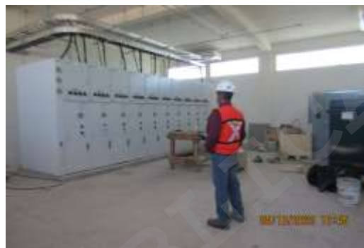
Figura II. 43 Instalación de equipos de la subestación eléctrica elevadora.
