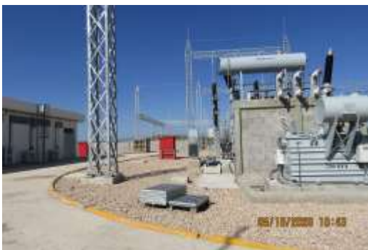
Figura II. 43 Instalación de equipos de la subestación eléctrica elevadora.
