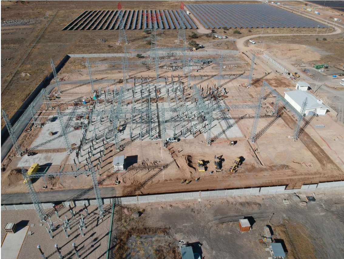
Figura II. 16. Estado actual de las actividades constructivas de la subestación eléctrica de maniobras del proyecto.
