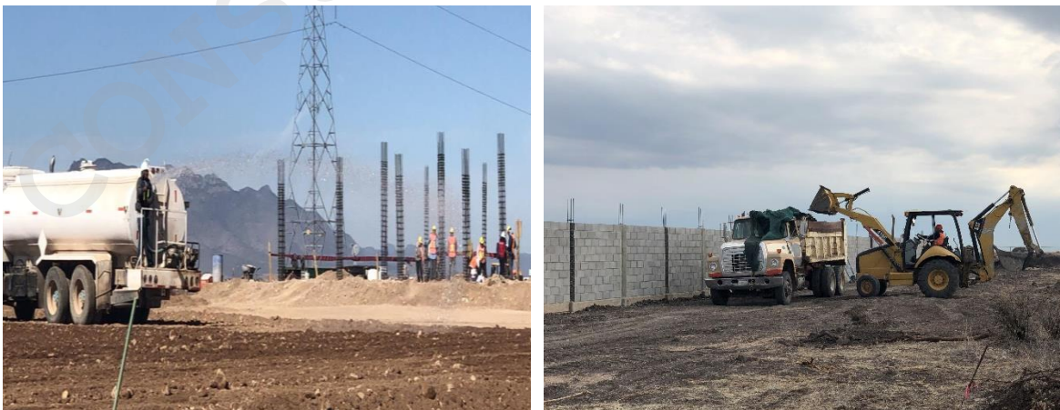
Figura II. 15 Actividades de construcción de la subestación eléctrica de maniobras
