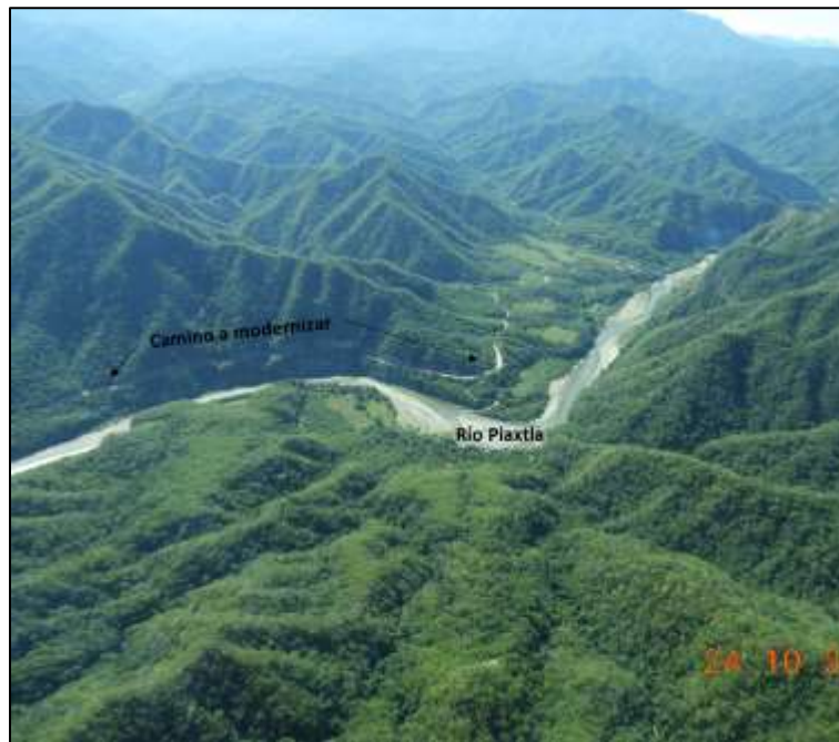
Figura IV.19 Vista aérea del río Piaxtla y el camino a modernizar.
