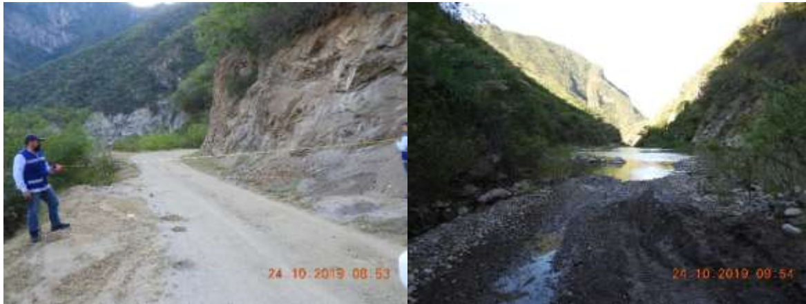
Figura VII.2 Vista de las condiciones actuales del camino Tayoltita – Límites Sinaloa/Durango.
