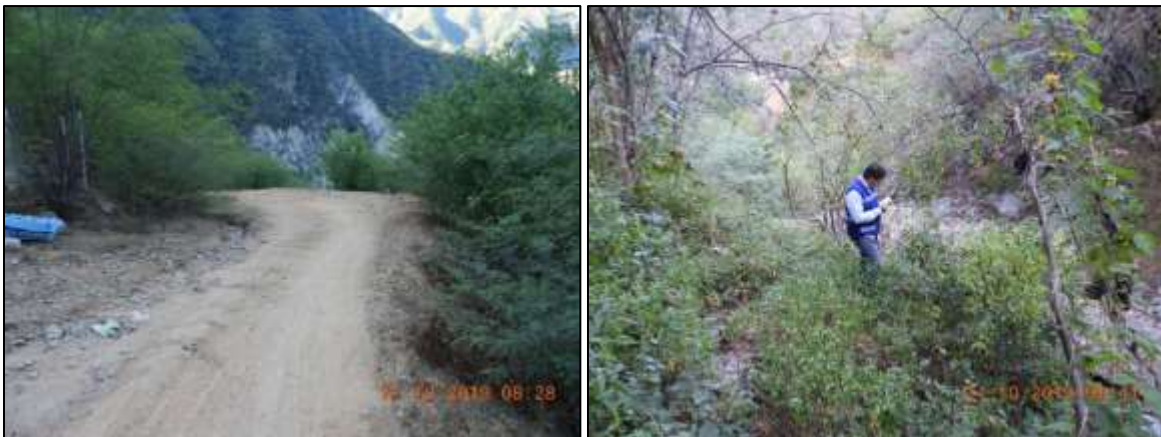
Figura IV.4 vista del camino actual que albergará la carpeta asfáltica de 7 m de ancho; fotografía izquierda, camino existente que será modernizado, fotografía derecha, zona de apertura nueva.
