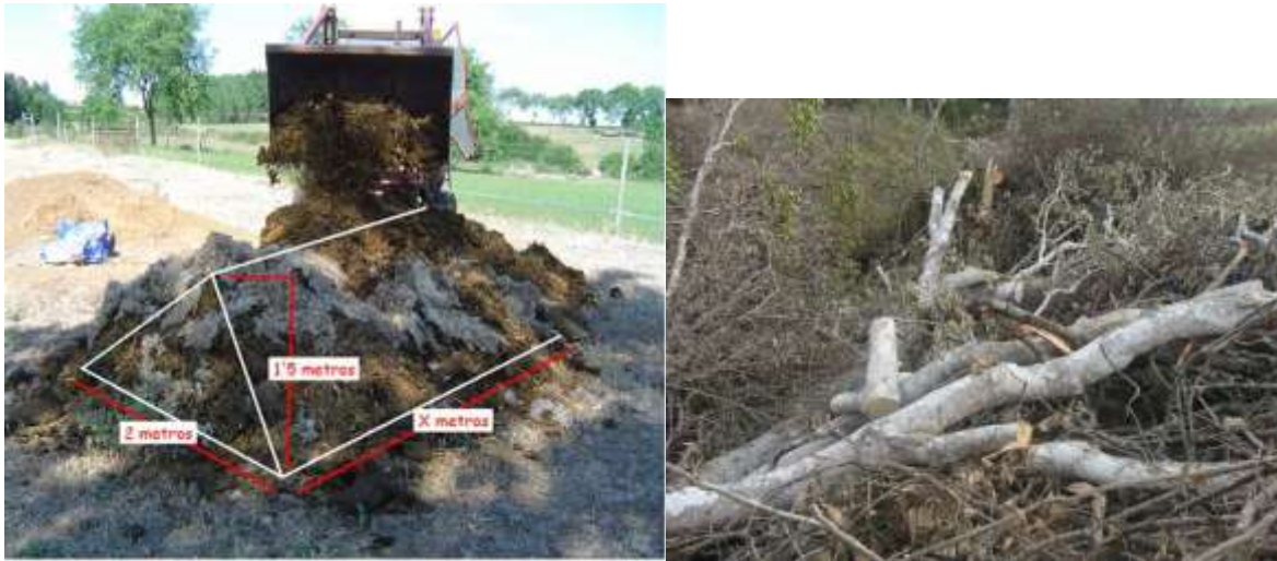
Figura V.6 Ejemplo del amontonamiento del suelo natural resultado del despalme
