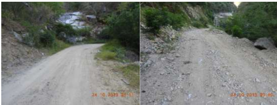
Figura II.1 Vista de las condiciones actuales del camino.
