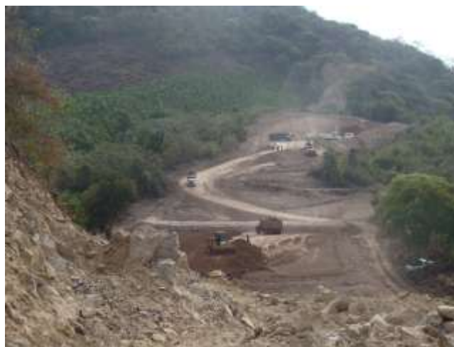
Figura V.5 Ejemplo de las actividades de construcción de un avía de comunicación similar
