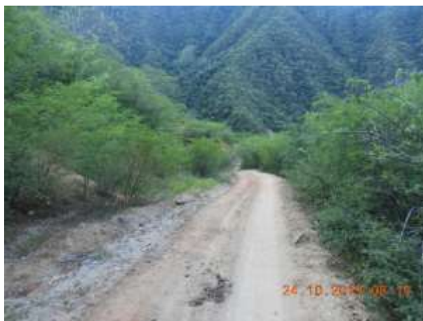
Figura IV.3 vista del camino actual que albergará la carpeta asfáltica de 7 m de ancho.
