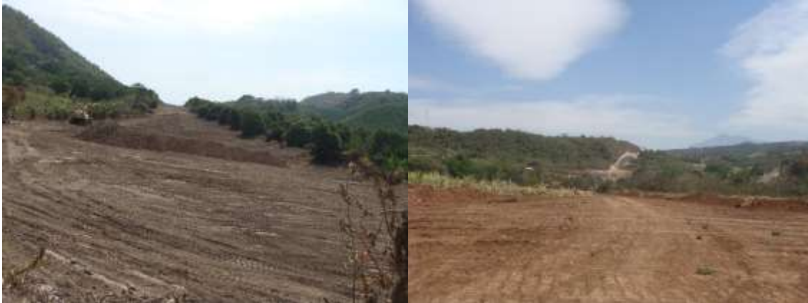
Figura V.4 Ejemplo del desmonte en un proyecto similar
