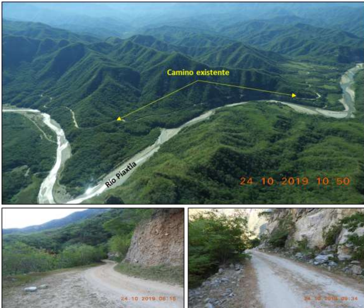
Figura II.2 Vista de las condiciones actuales del camino.
