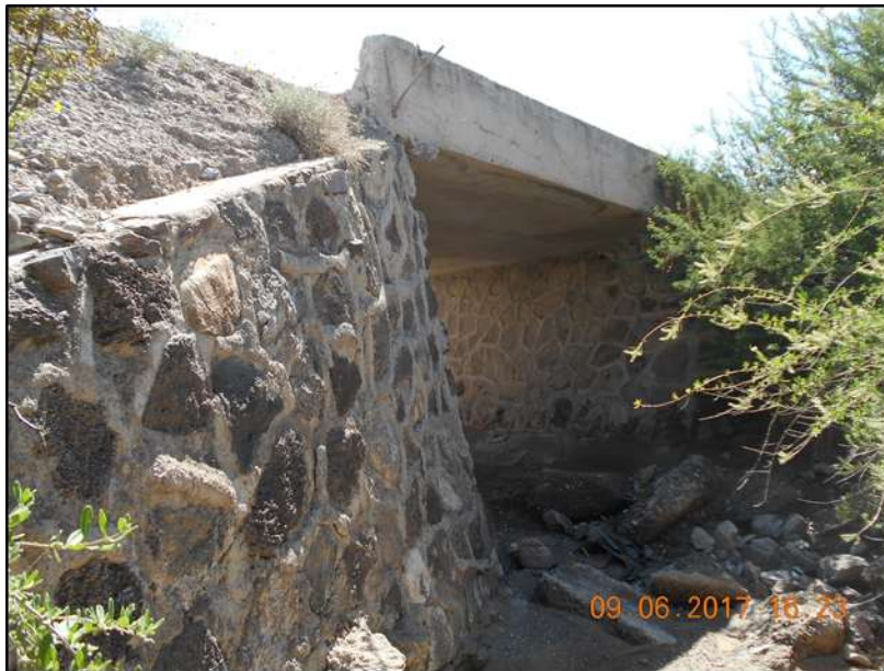
Figura VI.23 Ejemplo de una obra de drenaje en la zona del proyecto "Modernización del camino San Ignacio – Tayoltita, tramo límite entre los estados de Sinaloa/Durango – Tayoltita del km 89+600 al km 102+160" la cual tendrá que ser modernizada a un paso de fauna.
