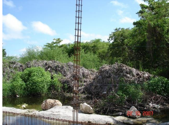
Foto VI.6. Ejemplo del manejo de residuos de desmonte; y ejemplo de manejo de residuos de desmonte. Los residuos vegetales fueron colocados en un sitio para conformar una composta y posteriormente integrarlo a las labores del vivero temporal del proyecto.
