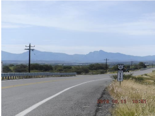
Foto II.1 Cadenamiento 110+000, inicio del Proyecto
