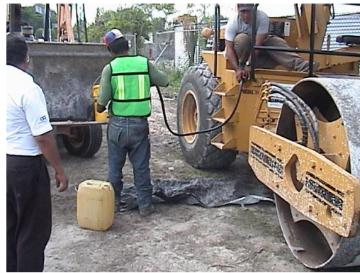
Foto VI.10. Ejemplo de carga de combustible in situ . Llenado de gasolina de una bomba para extraer el agua, debajo lado izquierdo se puede observar el uso de una lona para prevenir posibles derrames de combustibles sobre el suelo; y carga de diesel a un vibro compactador usando una lona sobre el suelo natural para evitar posibles derrames de combustible
