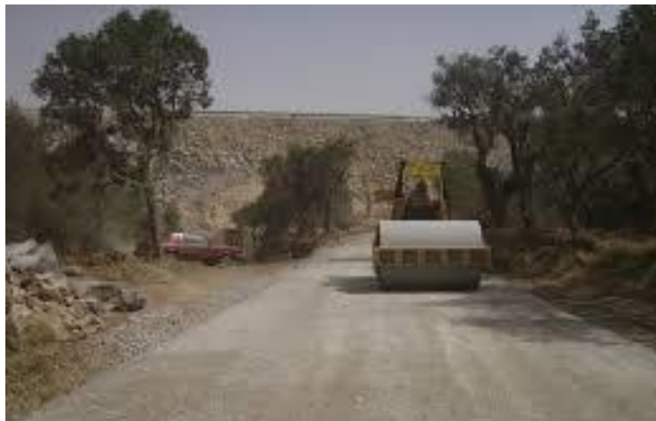
Foto II.17 Ejemplo de compactación de Base Hidráulica.
