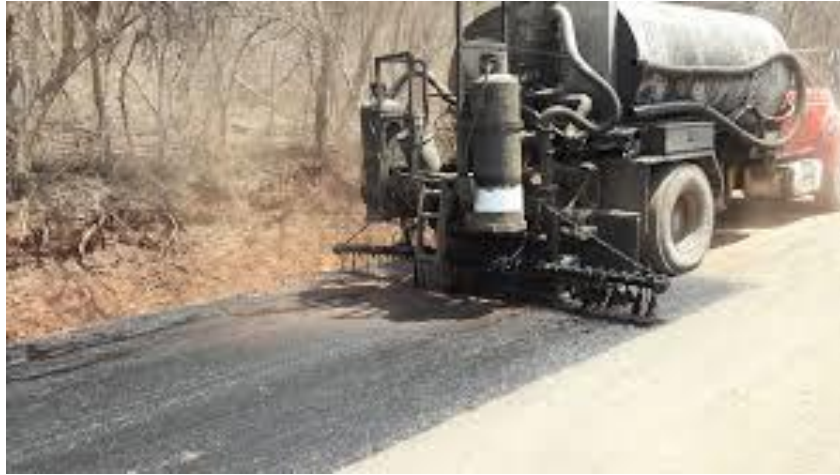
Foto II.18 Ejemplo de riego de liga.
