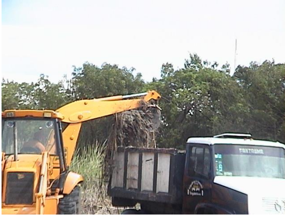
Foto VI.6. Ejemplo del manejo de residuos de desmonte; y ejemplo de manejo de residuos de desmonte. Los residuos vegetales fueron colocados en un sitio para conformar una composta y posteriormente integrarlo a las labores del vivero temporal del proyecto.
