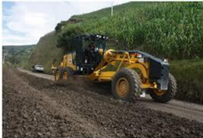
Foto II.16 Ejemplo tendido de subbase
