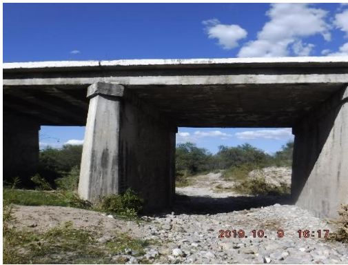
Foto II.3 Parte inferior del Puente Santa Ana, aproximadamente en el cadenamiento 121+800 de la actual carretera
