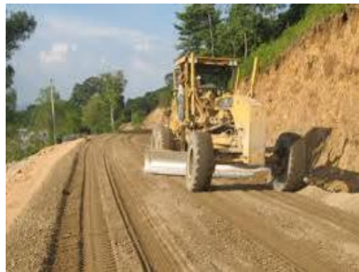
Foto II.13 Ejemplo de tendido de material
