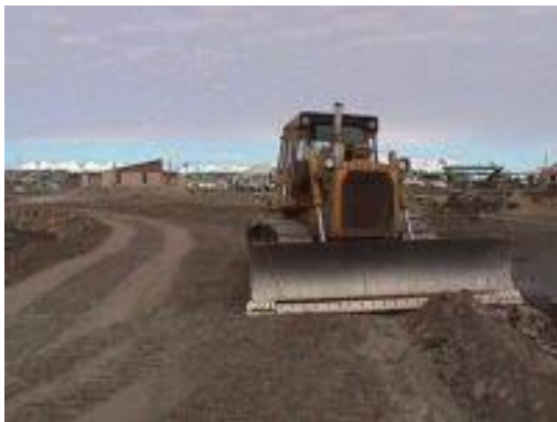
Foto II.12 Ejemplo de tendido de material
