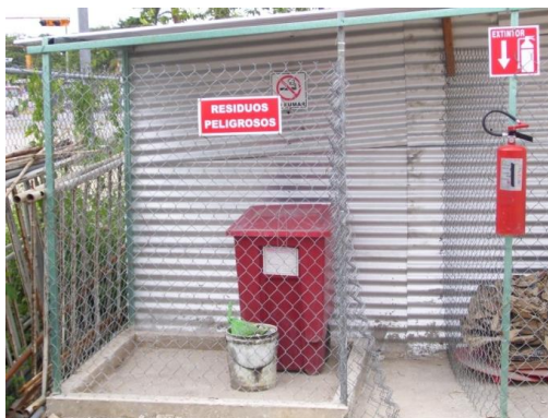
Foto VI.9. Sitio de acopio y almacenamiento temporal de residuos peligrosos, donde se indica el tipo de material resguardado en el área y se cuenta con un extintor señalado adecuadamente.
