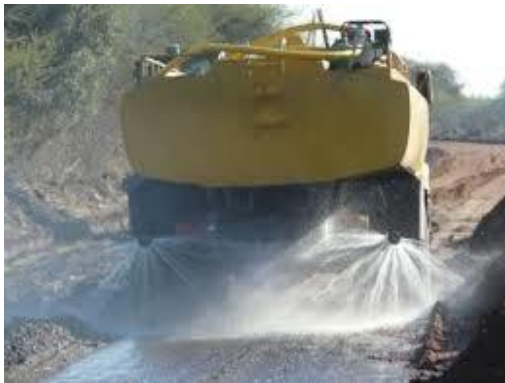
Foto II.14 Ejemplo compactación de suelo.
