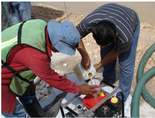
Foto VI.10. Ejemplo de carga de combustible in situ . Llenado de gasolina de una bomba para extraer el agua, debajo lado izquierdo se puede observar el uso de una lona para prevenir posibles derrames de combustibles sobre el suelo; y carga de diesel a un vibro compactador usando una lona sobre el suelo natural para evitar posibles derrames de combustible
