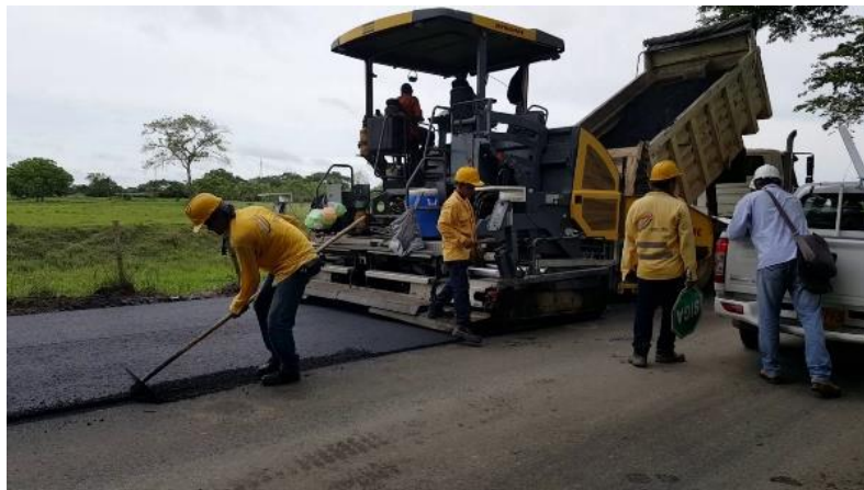
Foto II.19 Ejemplo de Carpeta de concreto asfáltico.
