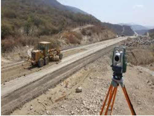
Foto II.10 Ejemplo de trazo y nivelación.
