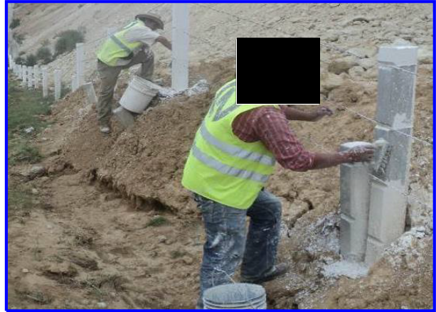
FOTOS VI.1.4.1.1 Y VI.1.4.1.2. COLOCACIÓN DEL ALAMBRE DE PÚAS -AMARRE Y TENSADO- Y PINTADO DE LOS POSTES (EJEMPLO)
