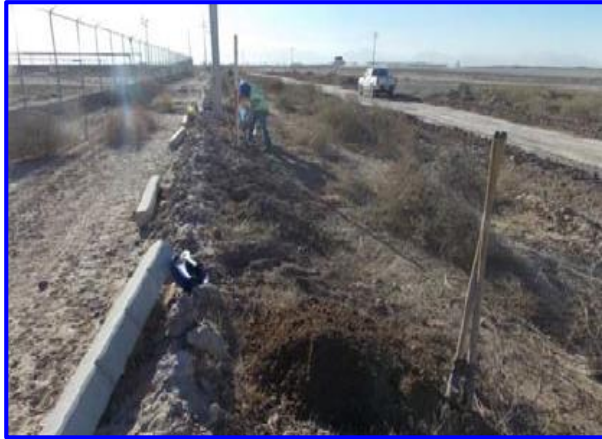
FOTOS VI.1.4.1.1 Y VI.1.4.1.2. COLOCACIÓN DEL ALAMBRE DE PÚAS -AMARRE Y TENSADO- Y PINTADO DE LOS POSTES (EJEMPLO)
