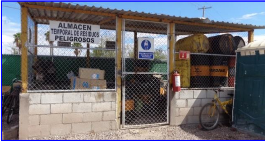
FOTO VI.1.4.5.5. VISTA DE UN EJEMPLO DE ALMACÉN TEMPORAL DE RESIDUOS PELIGROSOS
