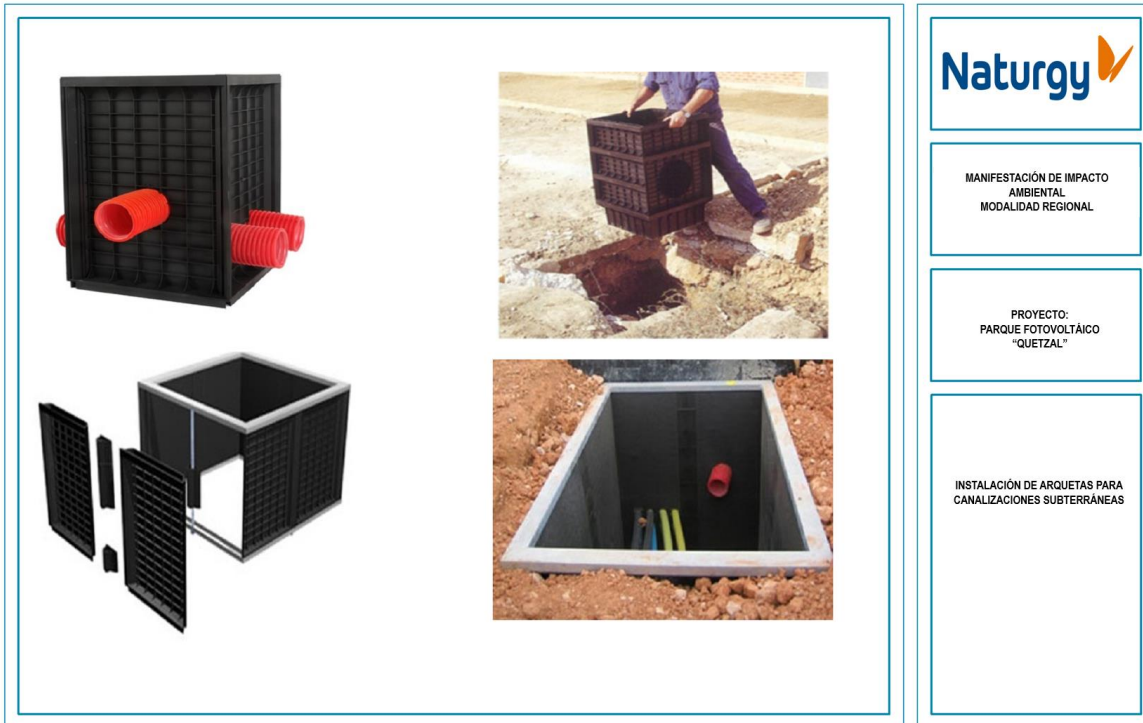
Figura II.9. Instalación de arquetas para canalizaciones subterráneas
