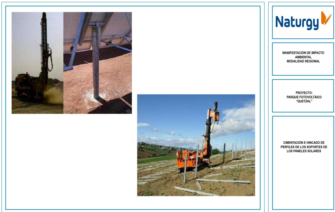
Figura II.8. Cimentación e hincado de perfiles de los soportes de los paneles solares
