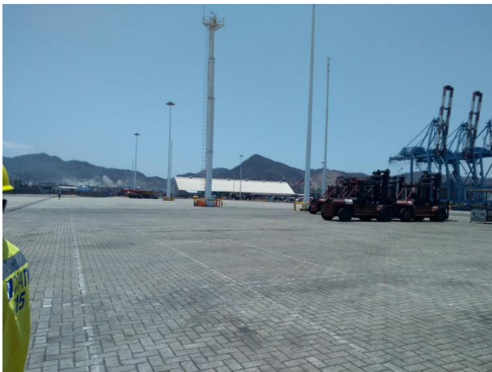
Fotografía No.4.- Área de plataforma, vista hacia el sureste.
