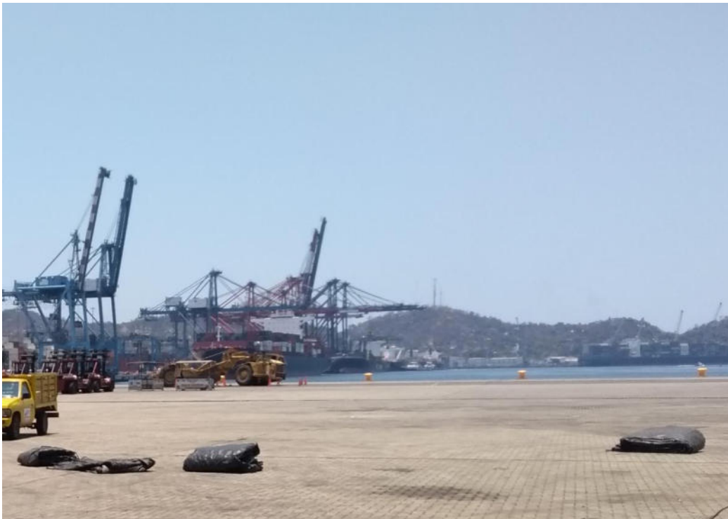
Fotografía No.6.- Área de plataforma, vista hacia el sur.
