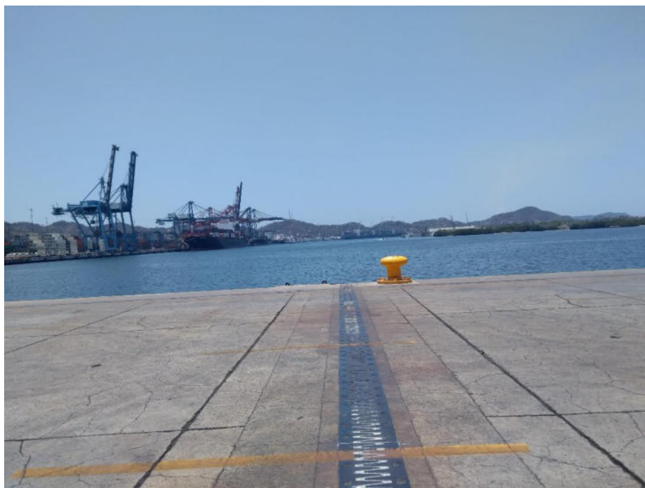
Fotografía No.2.- Área de muelle, vista hacia el sur.
