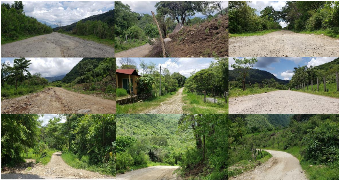
Estado actual de la vegetación dentro del SAR
