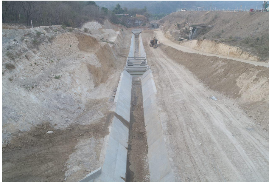
Fig. VII. 3 Obras para rencauzar el arroyo. Fuente: Imagen ilustrativa proporcionada por la promotora.
