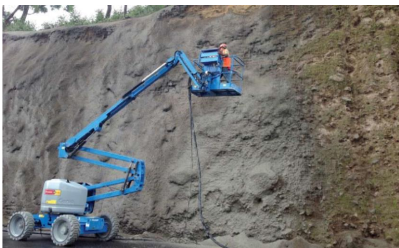
Fig. II.21 Aplicación de concreto lanzado en taludes de corte para el canal de desvío.
