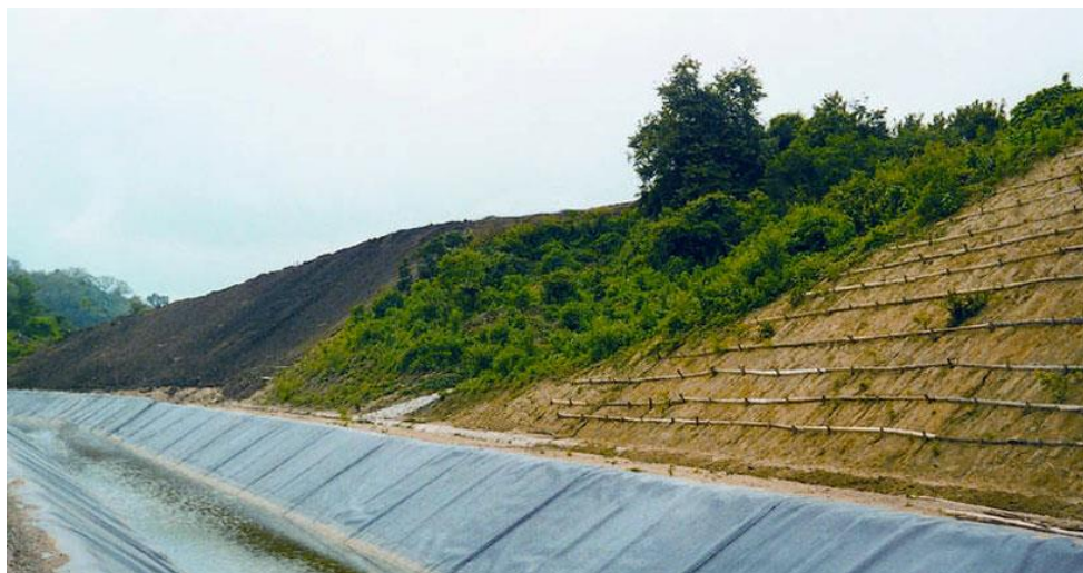
Fig. II.26 Ejemplo de la conformación de taludes mediante hidrosiembra.
