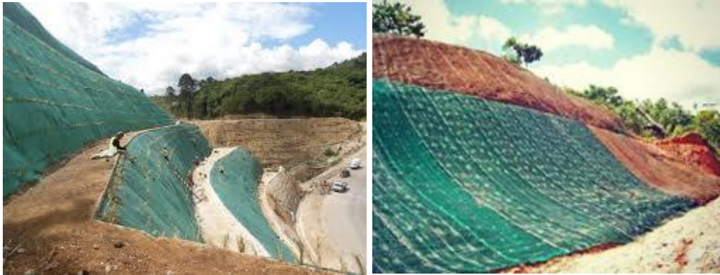
Figura VII-4. Ejemplo de estabilización de taludes por hidrosiembra en banco de materiales.
