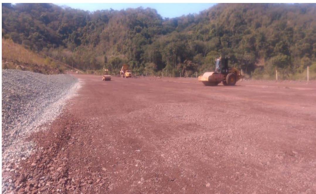
Fig. II.14 Trabajos de reconformación de Terraplén.
