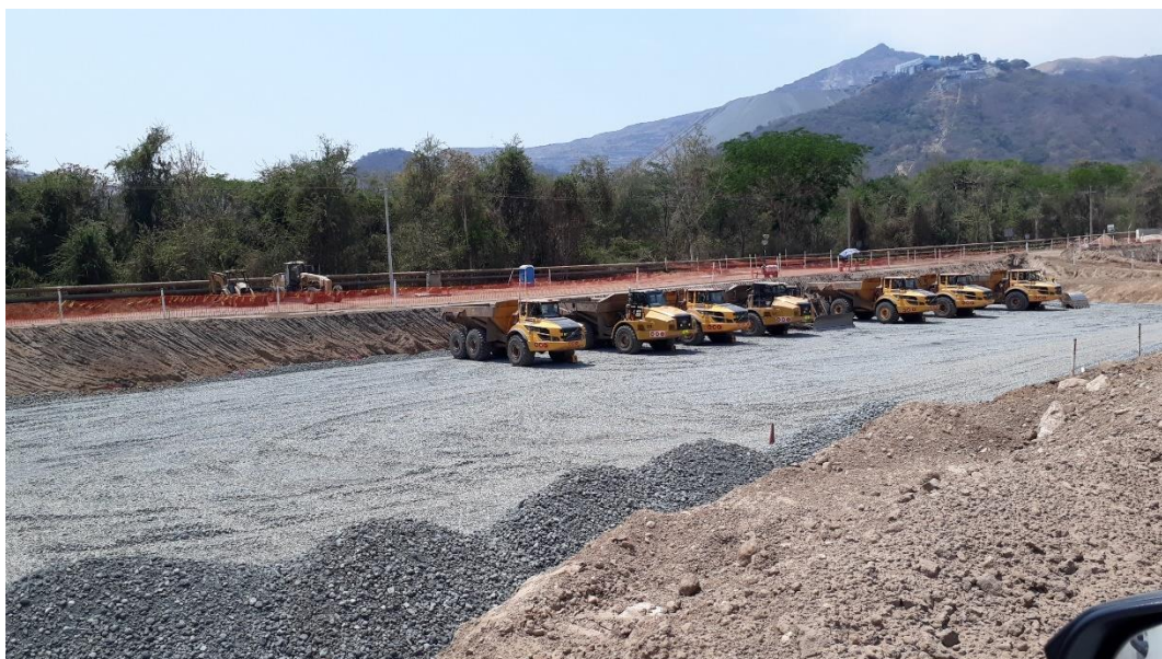
Fig. II.13 Construcción de tapetes drenantes.
