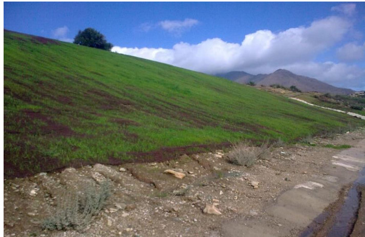
Figura VII-2. Ejemplo de estabilización de taludes por hidrosiembra.
