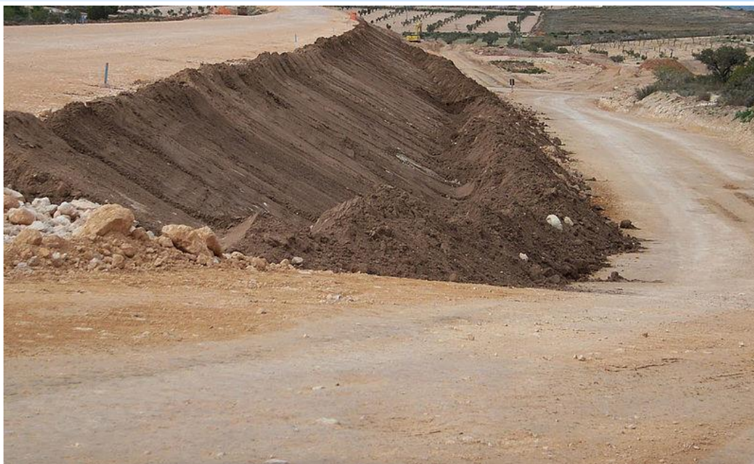
Fig. II.15 Conformación de terraplén
