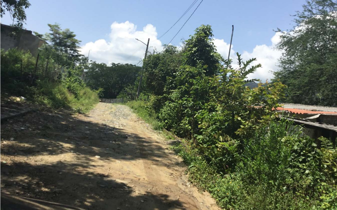
Foto 2. Vista del camino en zona urbana
