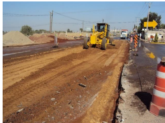
Foto II.9 Ejemplo de Tendido de material.
