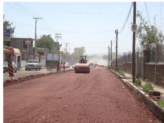
Foto II.11 Ejemplo compactación de suelo.
