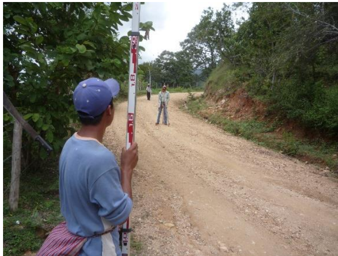
Foto II.5 Ejemplo de Levantamiento Topográfico.
