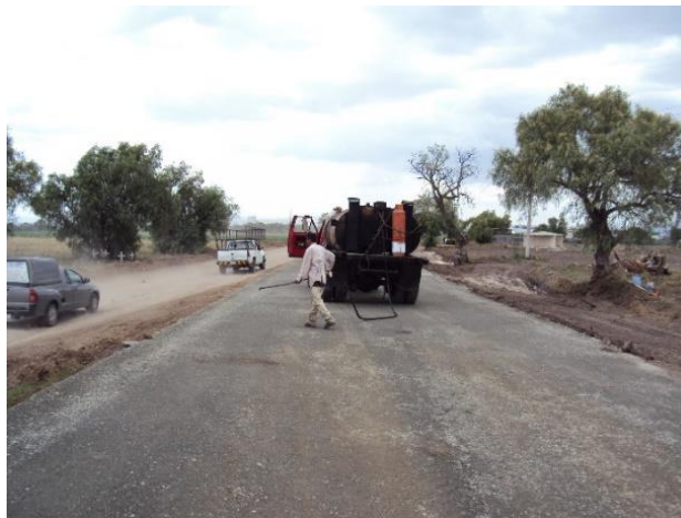
Foto II.14 Ejemplo de riego de liga.
