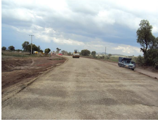
Foto II.13 Ejemplo de compactación de Base Hidráulica.
