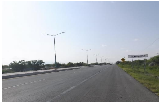
Foto II.2 Carretera Monclova – Piedras Negras, tramo Monclova-Sabinas, a la altura de la comunidad Hermanas en el km 44+000
