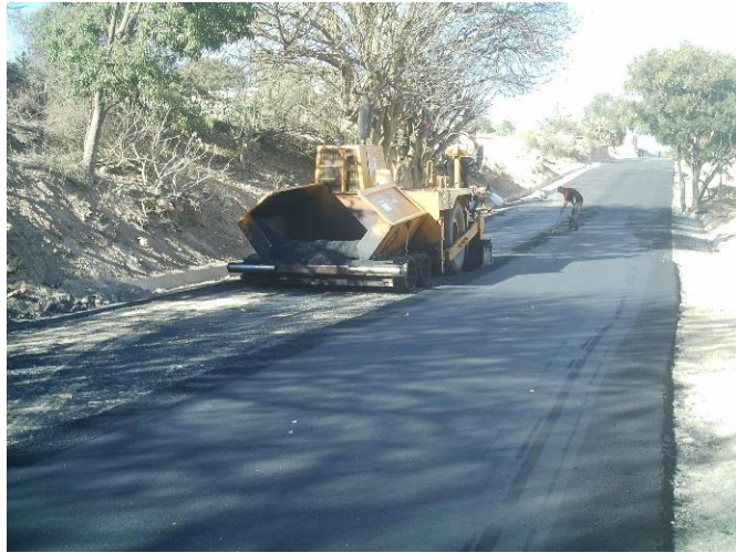
Foto II.15 Ejemplo de Carpeta de concreto asfáltico.
