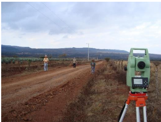
Foto II.6 Ejemplo de Trazo y Nivelación.
