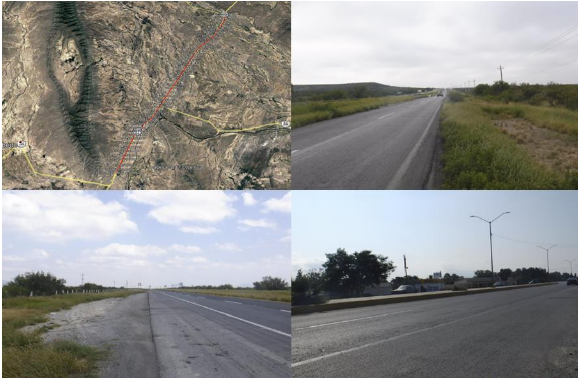
Foto IV.18. Toma aérea del Proyecto y vistas de la actual carretera y los asentamientos ubicados al costado de esta.
