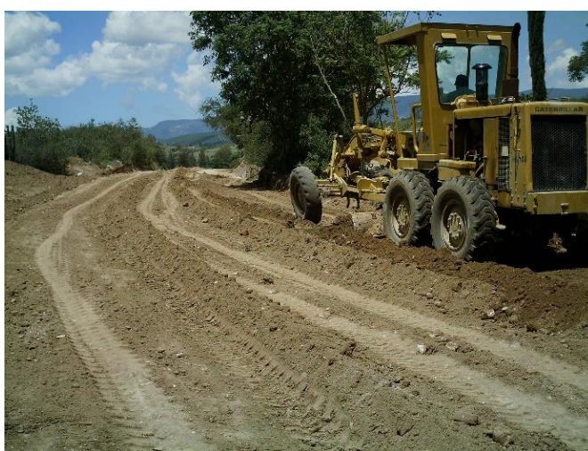
Foto II.12 Ejemplo tendido de subbase
