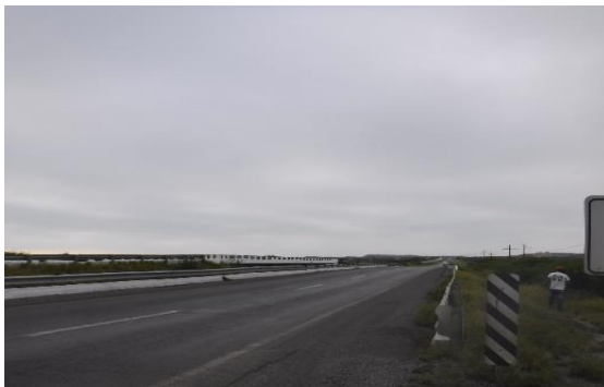
Foto II.1 Carretera Monclova – Piedras Negras, tramo Monclova-Sabinas, Puente El Sauz en el km 88+200
