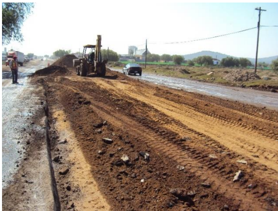
Foto II.8 Ejemplo de extendido de material.
