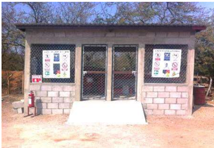
Figura II.12 Instalación del almacén de residuos peligrosos (ejemplo)
