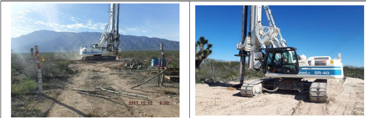
Figura II.18 Perforación de pilas de cimentación
