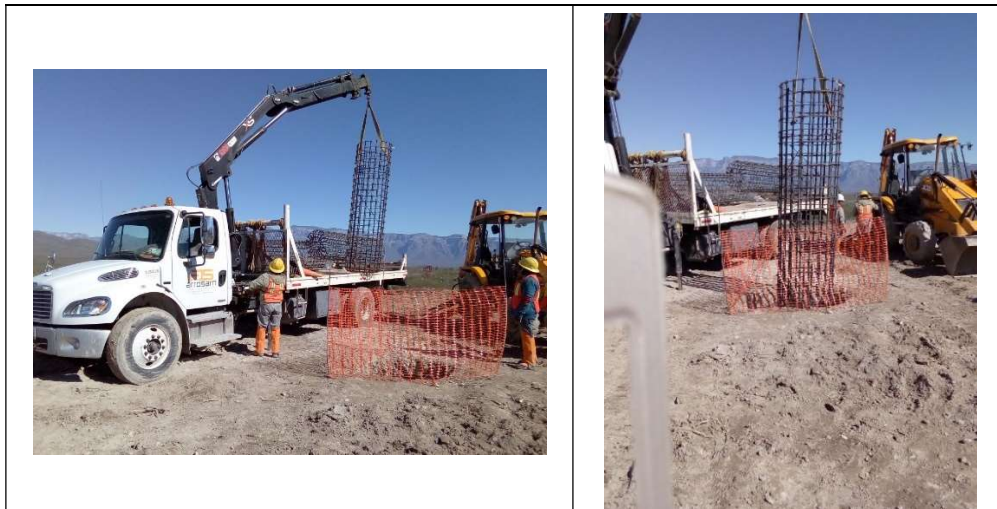
Figura II.19 Armado de acero de refuerzo y colocación
