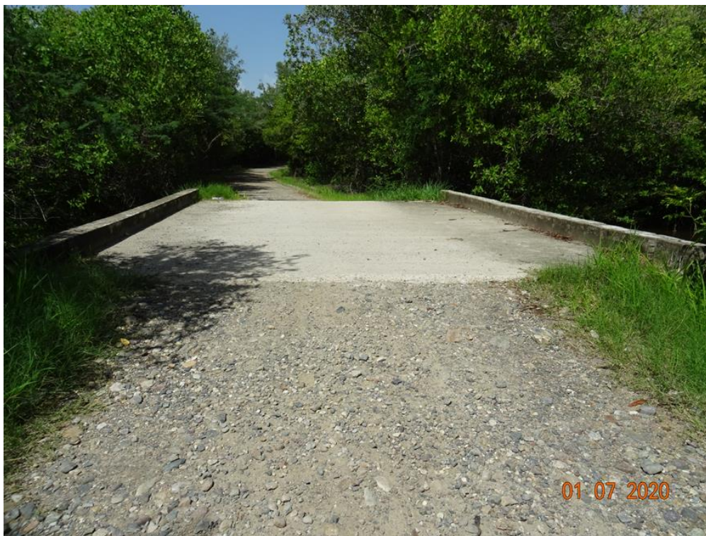
Figura II. 3. Puente existente en el camino actual.
