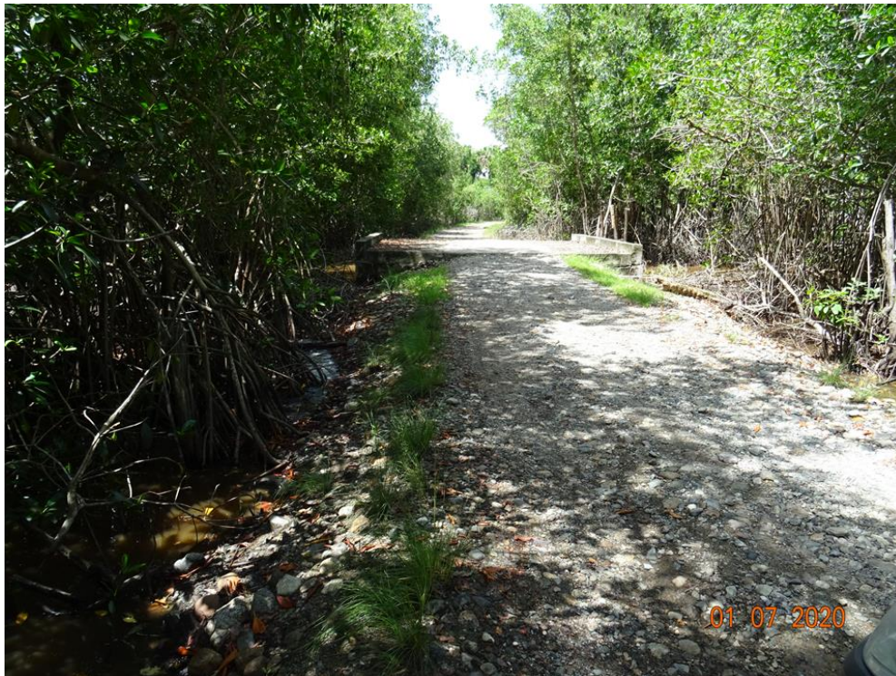
Figura II. 4. Obra de drenaje existente y vegetación de manglar colindante al camino actual.
