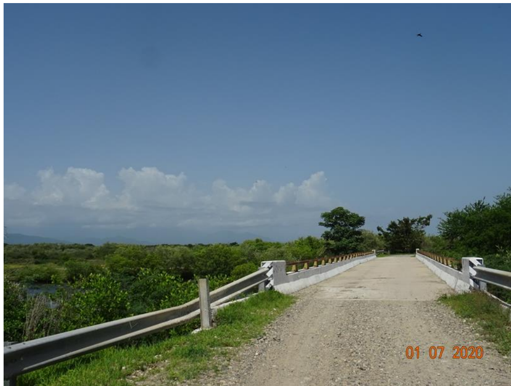
Figura II. 2. Puente existente en el camino actual.
