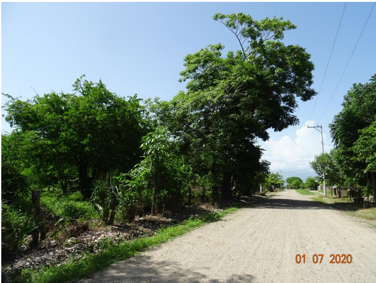
Figura II. 1. Condiciones actuales del camino en el kilómetro 7+000.
