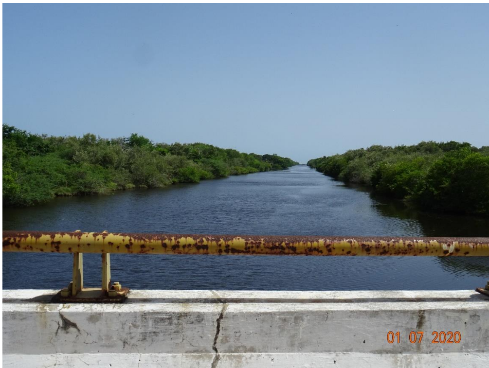
Figura IV. 77. Presencia de cuerpos de agua y vegetación de manglar.
