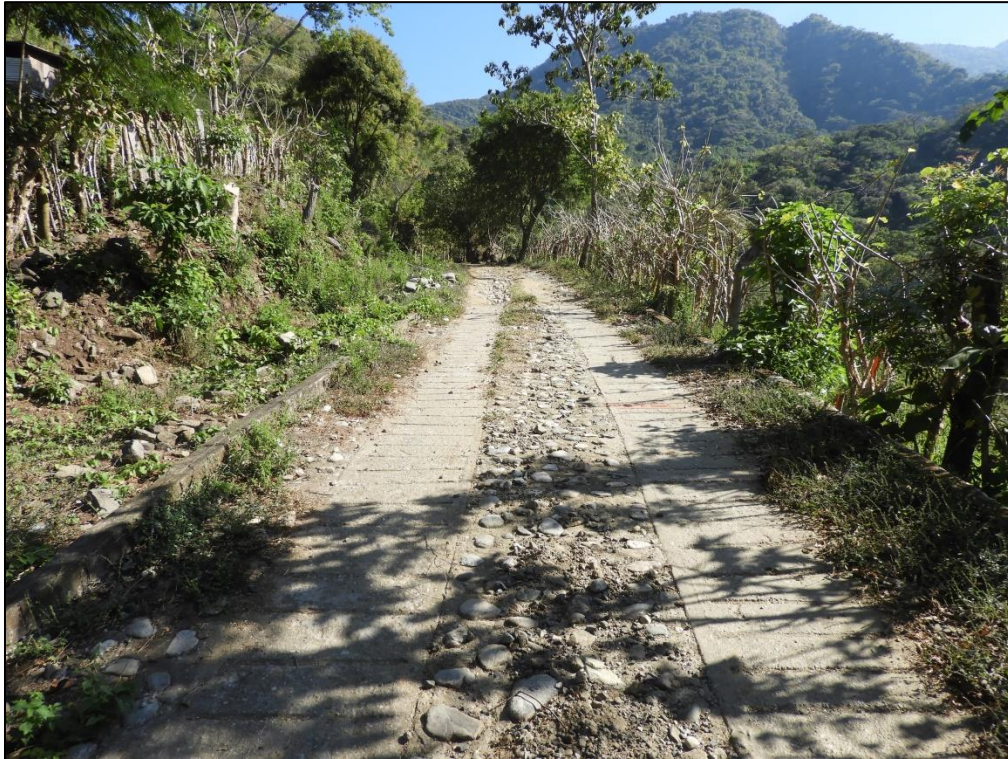
Figura II-7. Vista del Km 5+700, donde la ampliación del proyecto ocurrirá hacia el lado izquierdo, donde se observan cercos vivos.
