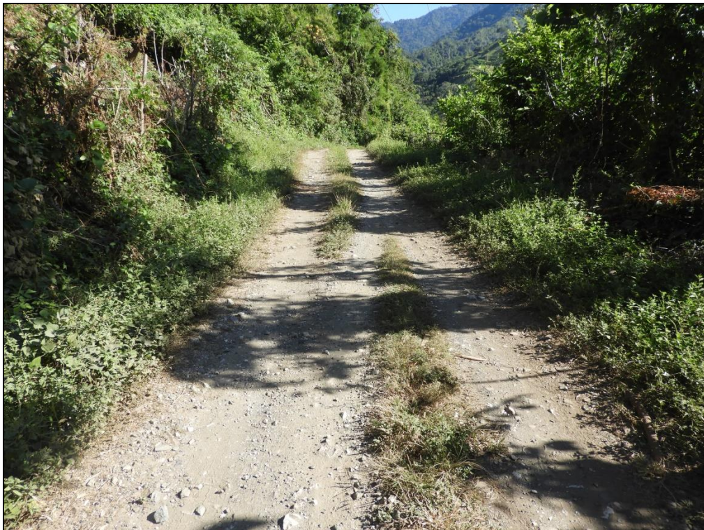
Figura II-4. Vista del proyecto en el Km 4+350.
