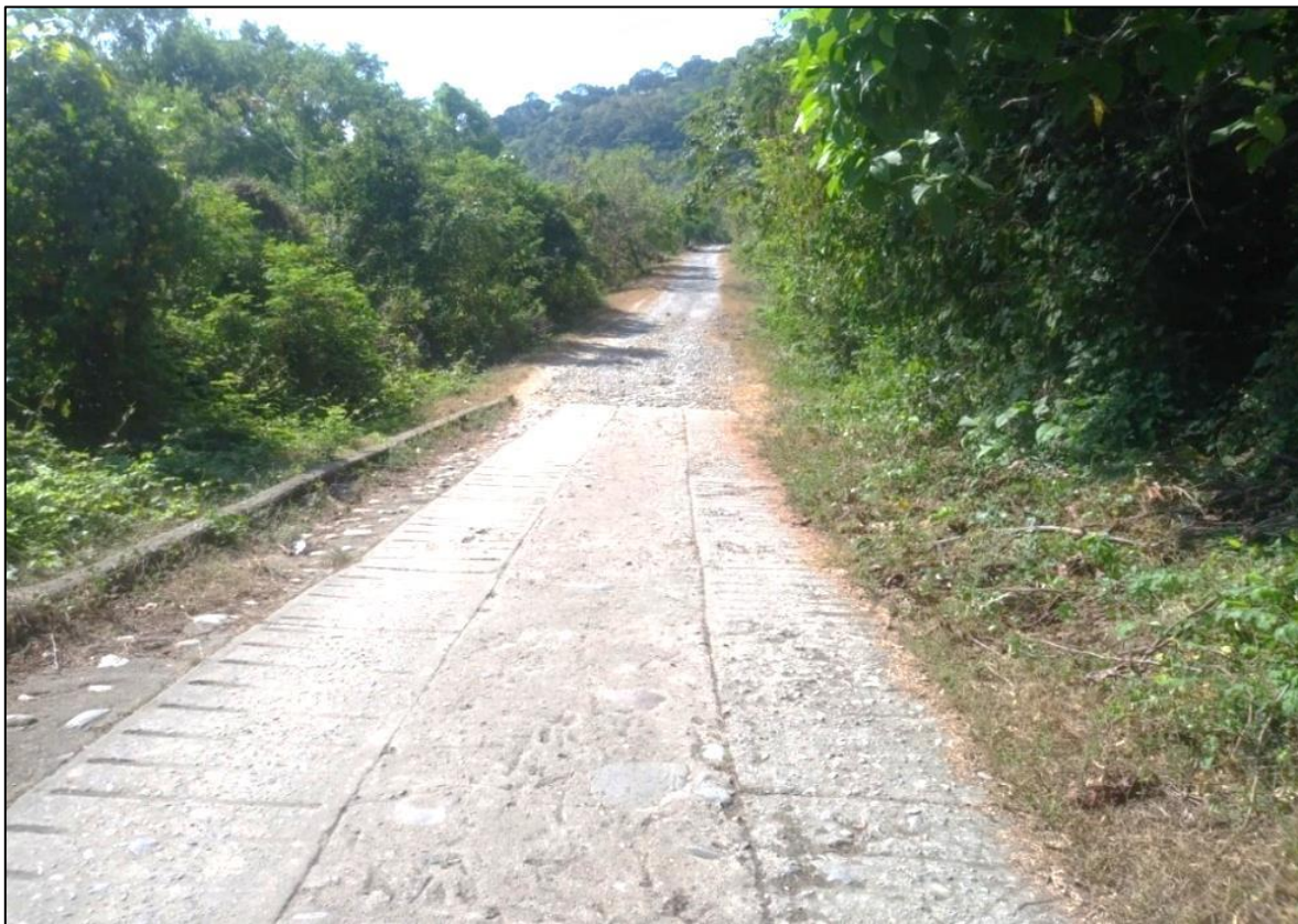
Figura IV-58. Características del camino que comunica Nueva Francia y Ovando La Piñuela, en el municipio de Escuintla, Chiapas.
