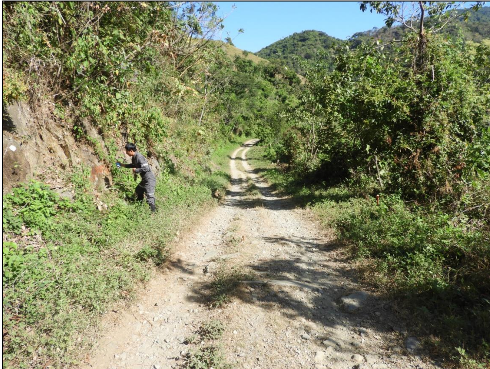
Figura II-5. Vista del proyecto en el Km 4+600 donde el camino existente no tiene el ancho necesario para pavimentarlo.
