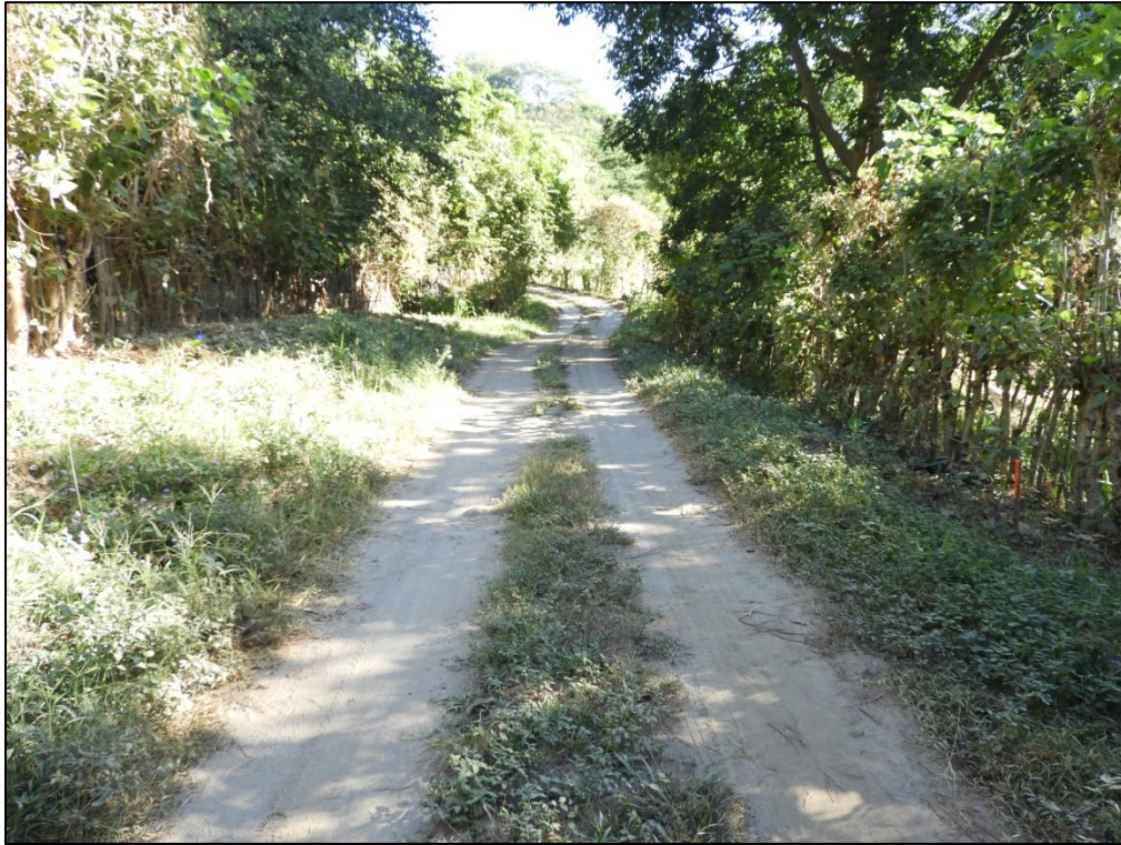
Figura II-3. Vista del proyecto Km 3+350.
