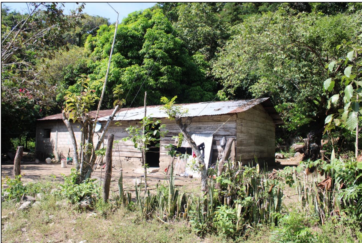
Figura IV-74. La imagen muestra dos viviendas en la comunidad de Rosarito La Piñuela, las cuales tienen techo de lámina, mientras las paredes son de madera y block.
