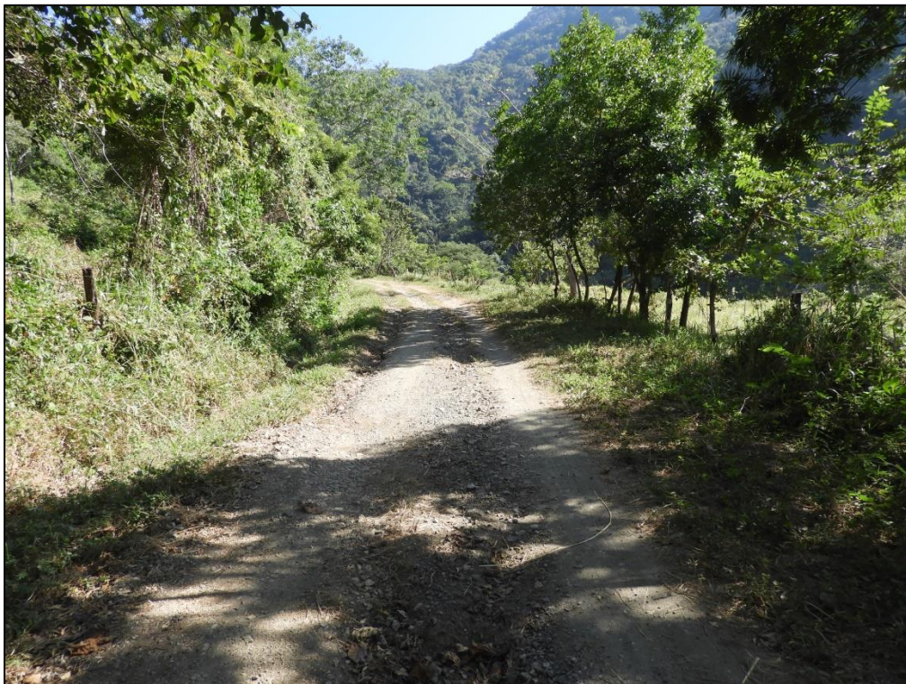
Figura II-8. Vista del Km 6+000 en dirección al Km 7+000, donde se realizara afectaciones a la vegetación colindante.
