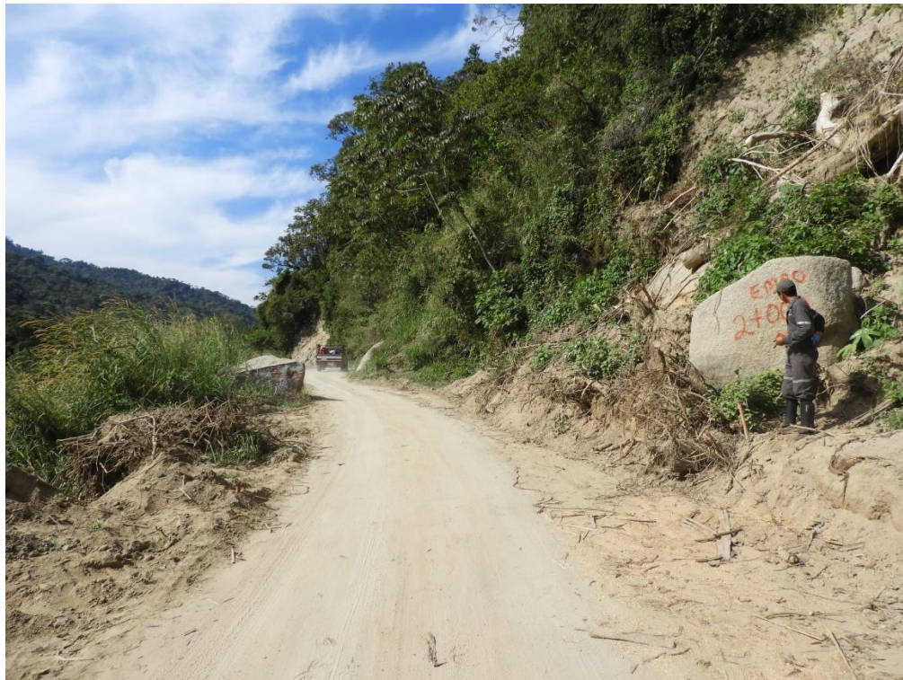
Figura II-8. Vista del Km 2+000 en dirección al Km 2+600, en esta área se realizarán cortes para evitar derrumbes.
