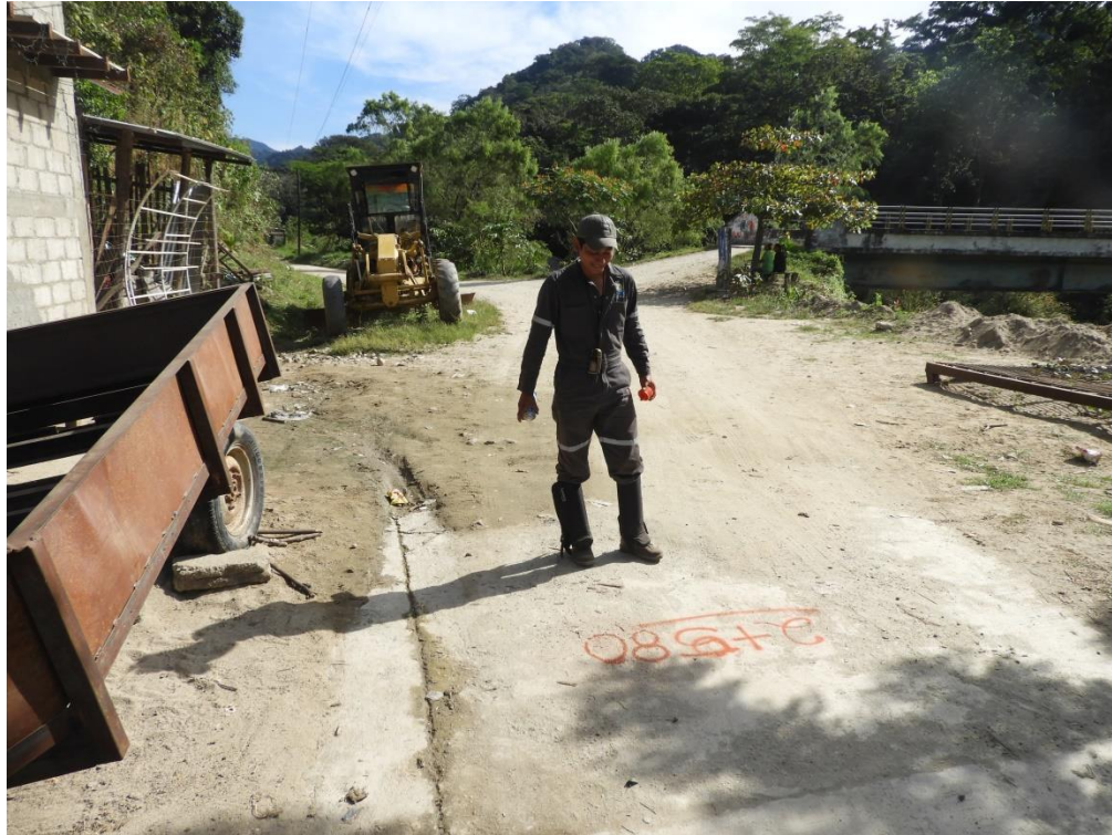
Figura II-9. Vista del Km 2+580 en dirección al Km 2+600, en esta área inician la infraestructura de viviendas de la comunidad de Ejido Nueva Maravillas.
