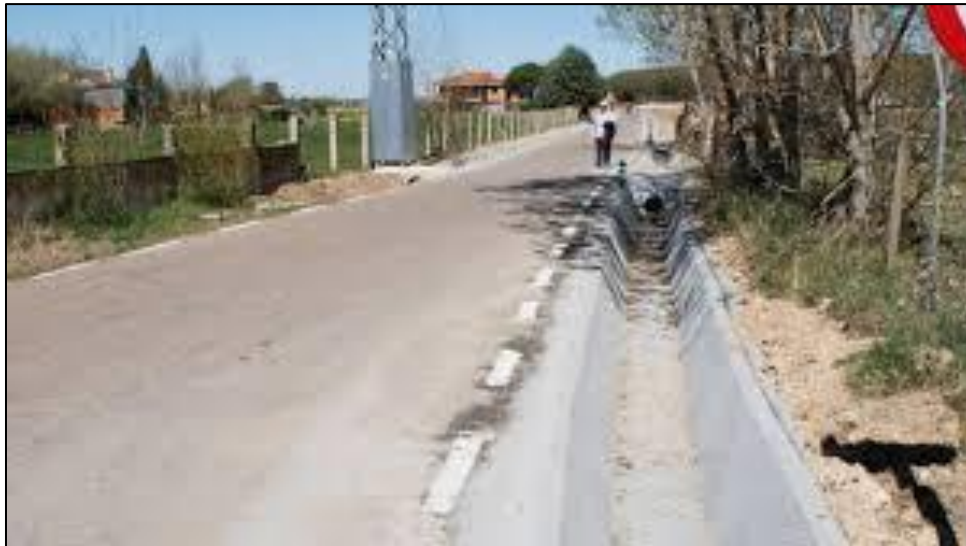
Figura V.10 Ejemplo de una obra de drenaje menor.
