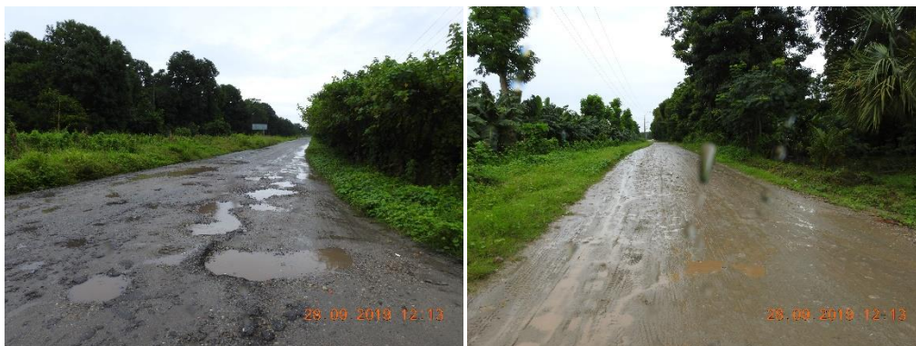
Figura II.1 Vista del camino de terracería que pretende modernizarse.
