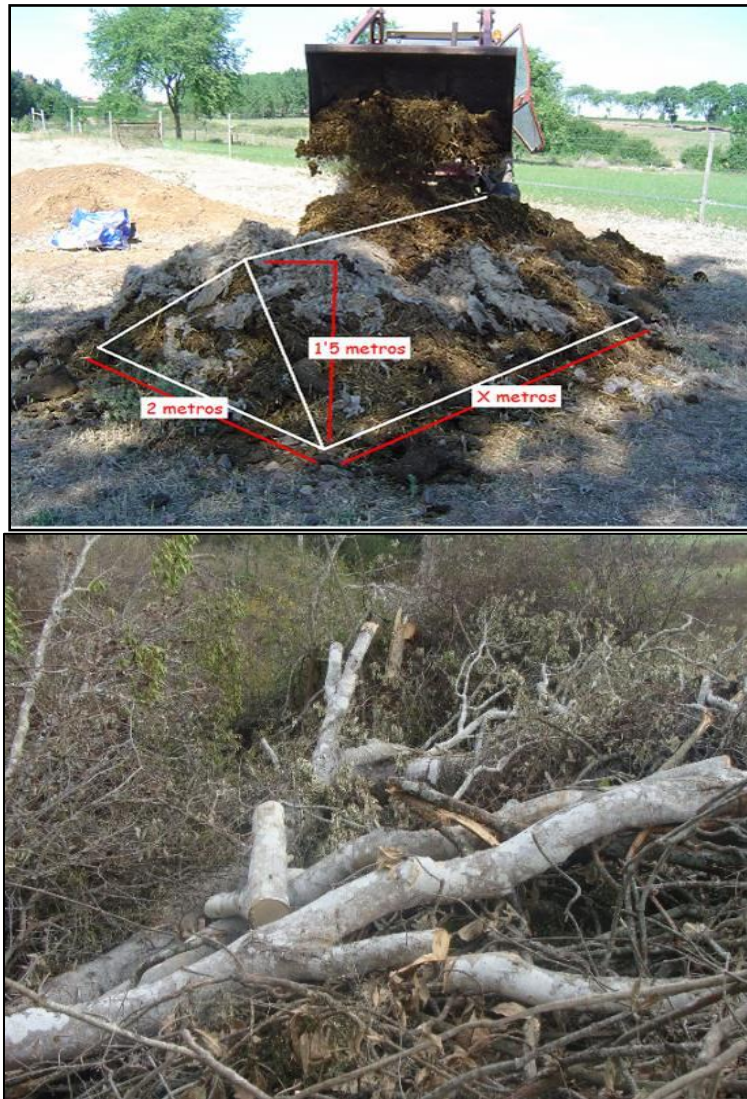
Figura V.6 Ejemplo del amontonamiento del suelo natural resultado del despalle
