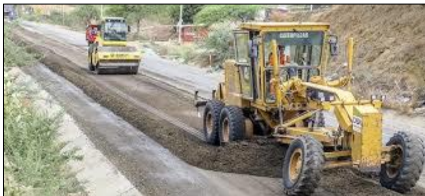
Figura V.5 Ejemplo de las actividades de construcción de un avía de comunicación similar
