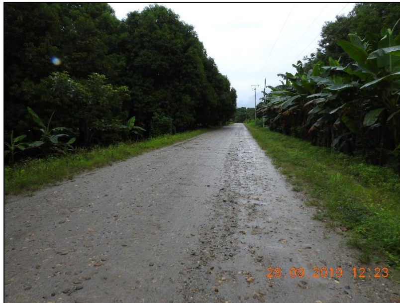
I.3 Vista de las condiciones actuales del camino.
