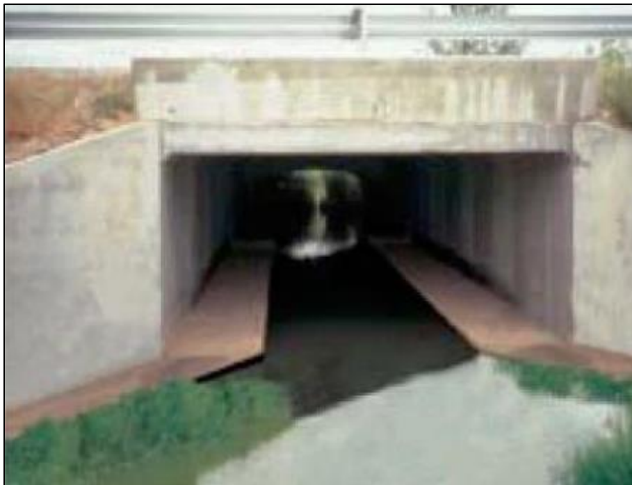
Figura VI.24 Ejemplo de pasos de fauna y obra de drenaje en obras similares.
