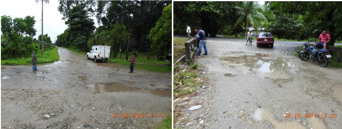
Figura II.9 Imágenes de los sitios de inicio y final del camino propuesto para modernización.
