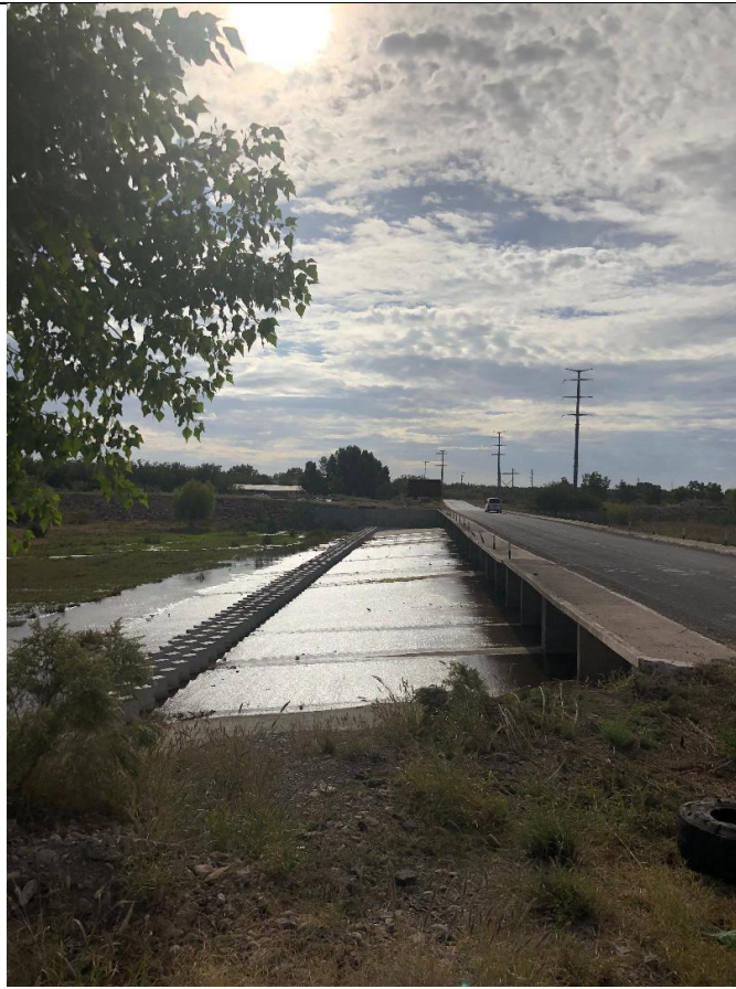
FOTOGRAFÍA 7. RIO SAN PEDRO AL FINAL DEL SISTEMA AMBIENTAL DONDE DESCARGA DREN.
