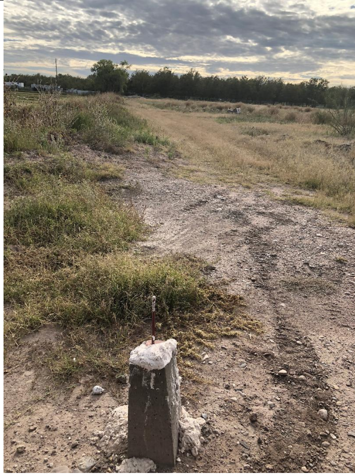
FOTOGRAFIA 4.- ESQUINA DEL PREDIO PARA LA CONSTRUCCIÓN DE LA PTARPCD
