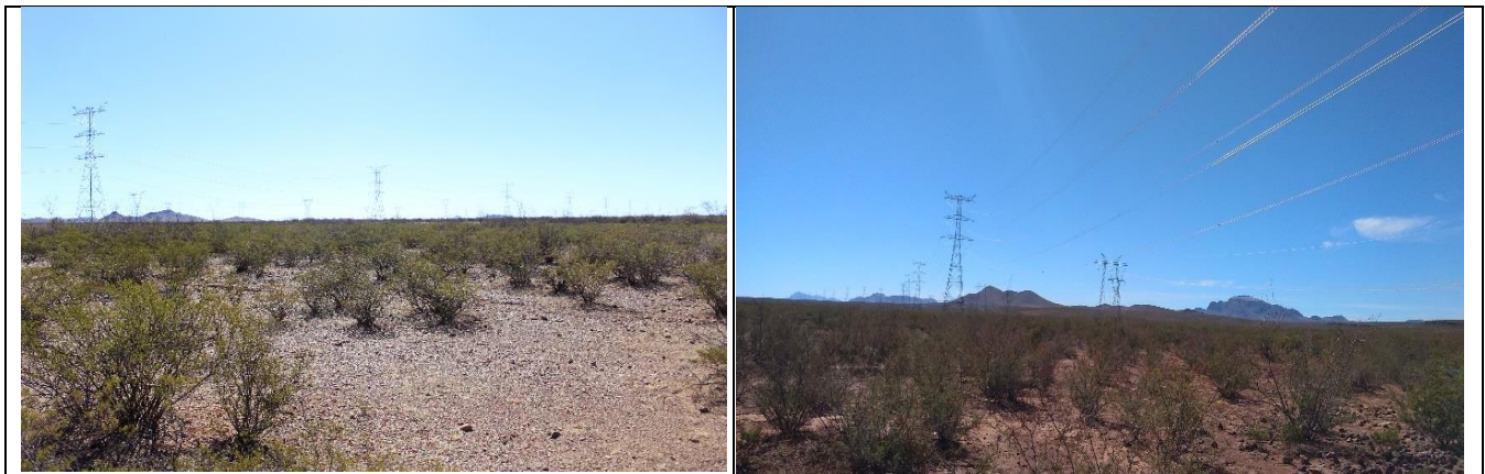
Figura 4 Condición de LT existente; infraestructura de circuito de alta tensión presente en el AI
