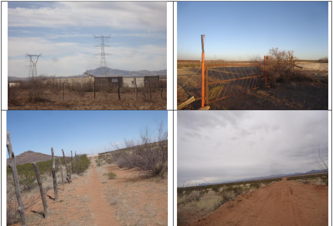
Figura 6 Estación de batería de presión ducto de PMX, circuito eléctrico de alta tensión y rancho pecuario en las inmediaciones sur del área de proyecto y accesos existentes al interior del AP.
