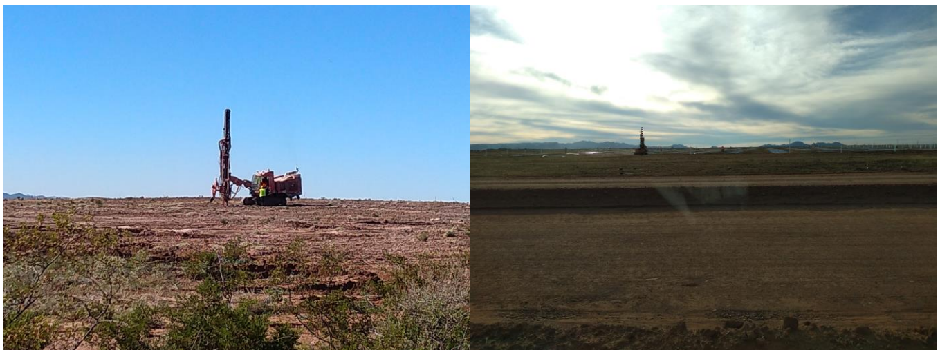
Ejemplos de máquinas hincadoras con trabajo a presión hidráulica, para instalado de autosoportes.
