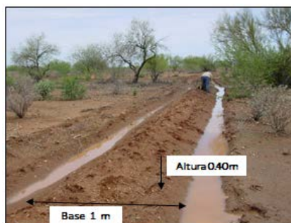
Figura VI.3 Dimensiones de bordo de tierra
