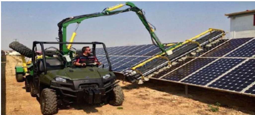
Figura II.23 Limpieza mecánica de los módulos fotovoltaicos
