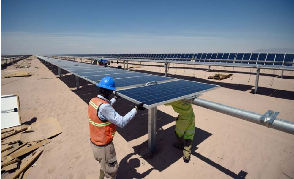
Figura II.19 Montaje de los módulos fotovoltaicos
