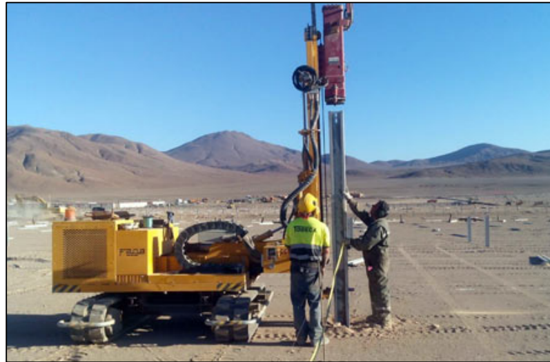
Figura II.16 Imagen ilustrativa del hincado de estructuras
