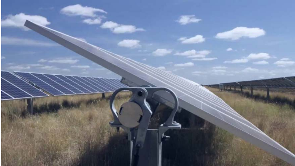
Figura II.17 Sistema de seguidores en los paneles solares
