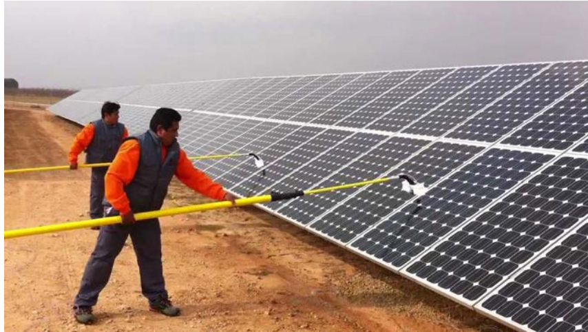
Figura II.21 Limpieza manual de los paneles solares
