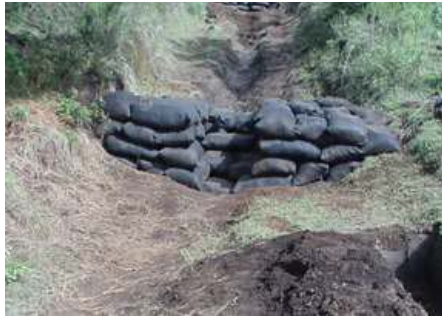
Figura VI.7 Ejemplificación del acomodo de las presas de geo costales
