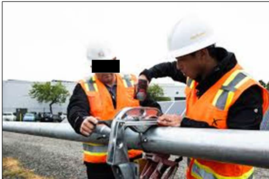
Figura II.18 Montaje de la estructura de soporte
