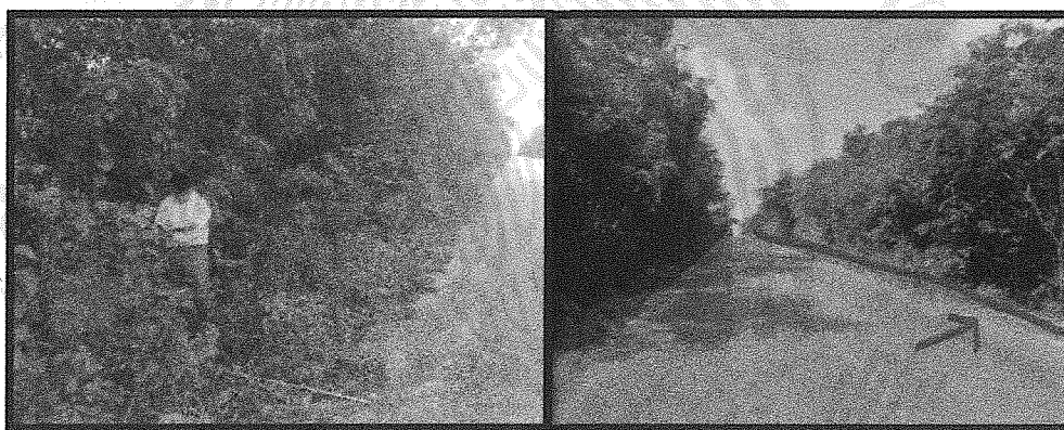
Panorámica del tramo a modernizar
