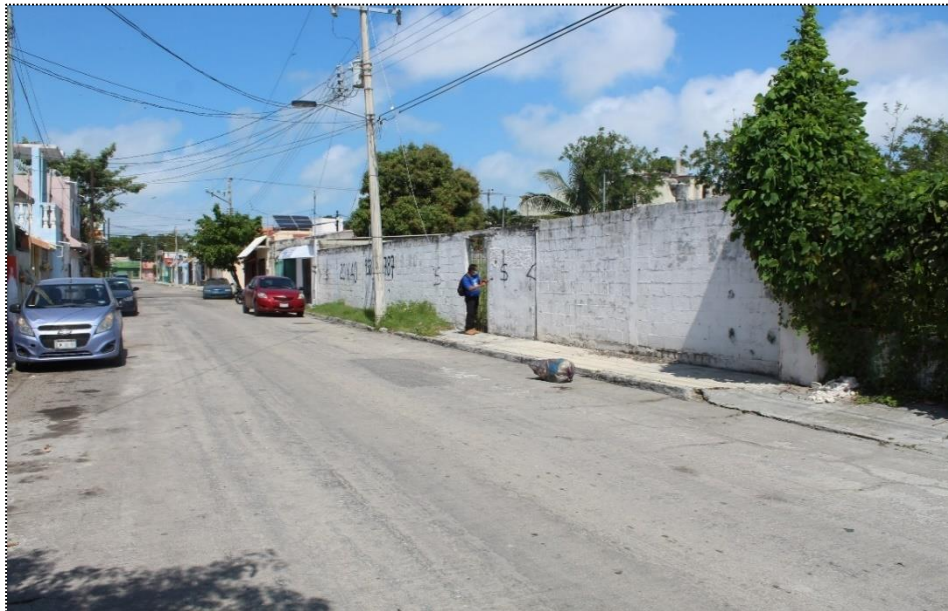
Fig. II.6 Energía eléctrica (postes de alumbrado público).
