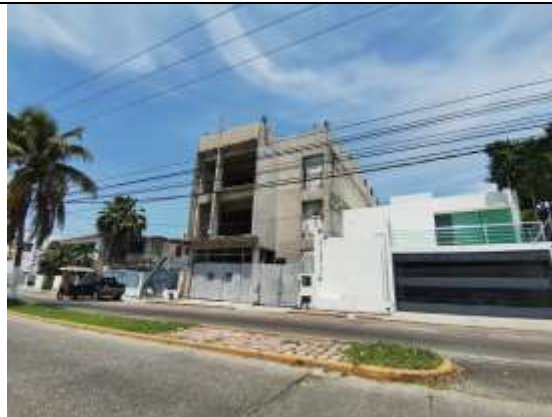
Imagen 2. Fachada derecha del edificio
