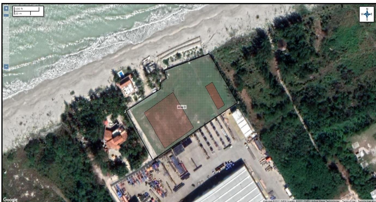
Imagen: Polígono del proyecto, NAVE 2 de almacenamiento de heramientas y patio de maniobras.
