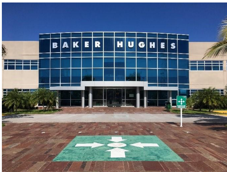
Imagen. - señalamientos en acceso principal.
