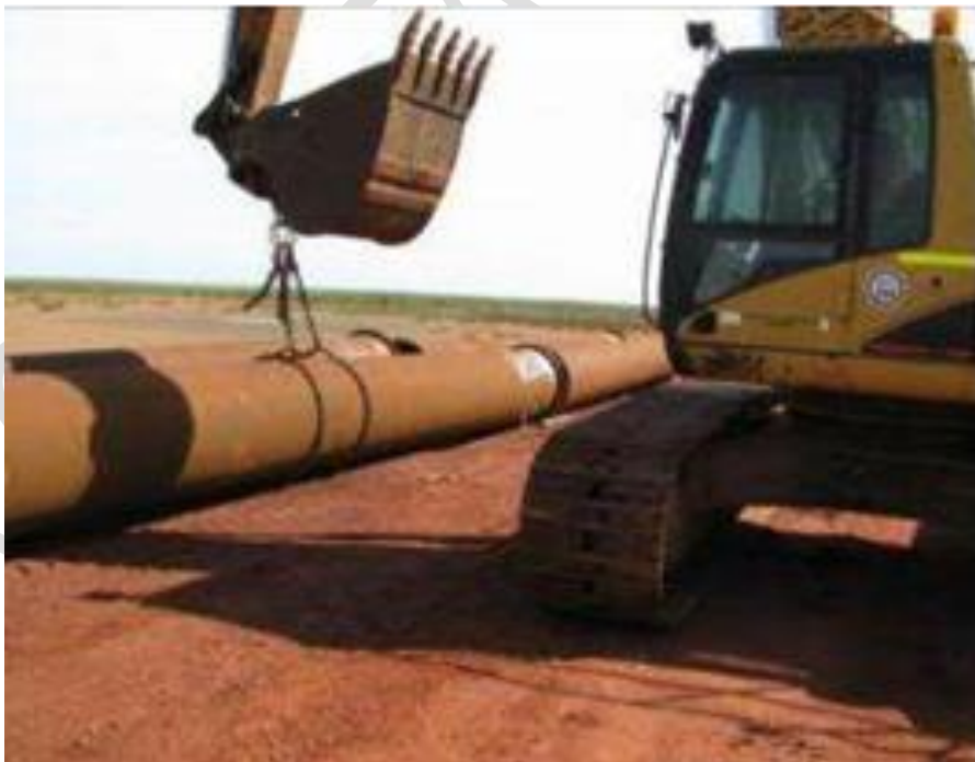
Figura XXXII. Ejemplo de retroexcavadora conectando una tubería.
