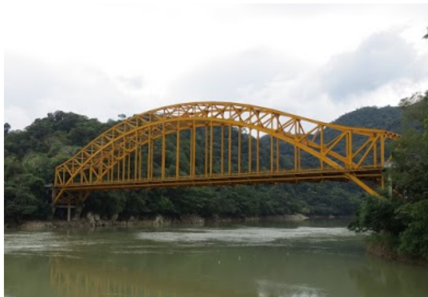
Figura IV.2.36. Puente boca del cerro en Tenosique, Tabasco, infraestructura de la línea férrea del Mayab que cruza el río Usumacinta
