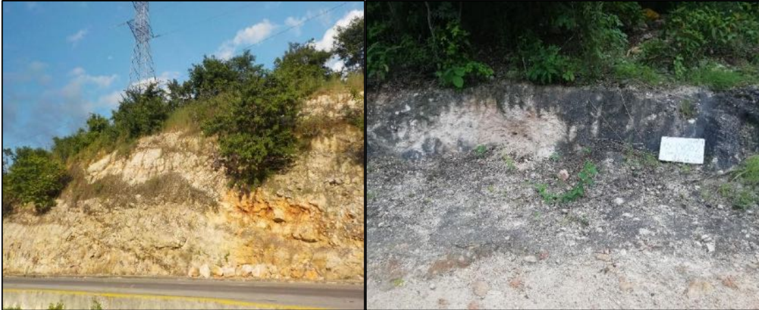
Figura IV.2.15. A) Expresión morfológica de la Falla Ticul sobre la carretera costera del Golfo a la altura de Maxcanú. B) Corte de menos de 1 m sobre la zona de falla. Se observa que sobre el eje del tren, la falla no tiene expresión morfológica.
