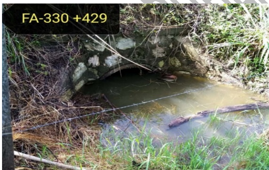
Figura IV.2.37. Estructura de drenaje de la línea férrea del Mayab
