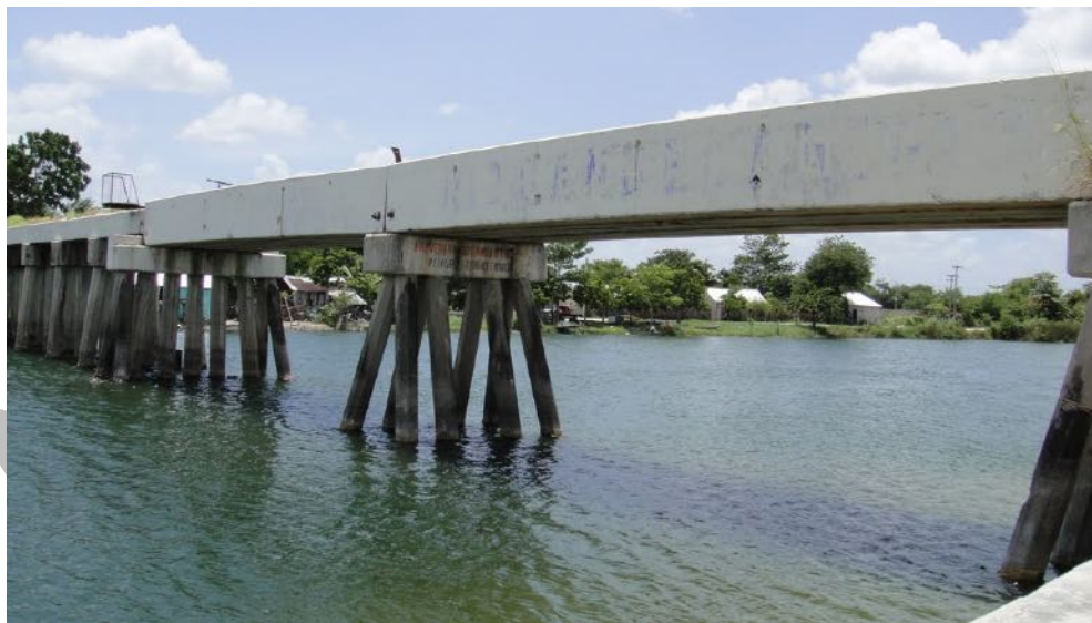
Figura IV.2.34. Puente en Candelaria, Campeche, infraestructura de la línea férrea del Mayab que cruza el río Candelaria.
