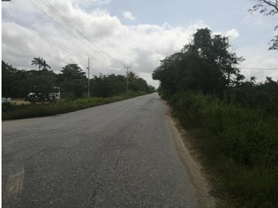
Imagen 16 Vista de la carretera federal Costera del Golfo en dirección hacia Isla del Carmen.
