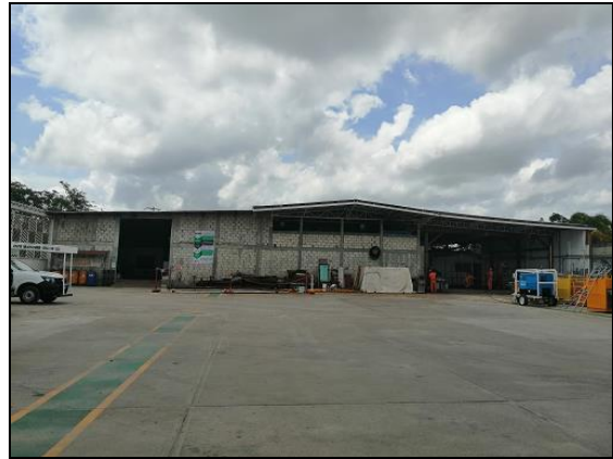
Fig. 19.- Patio de maniobras de las instalaciones
