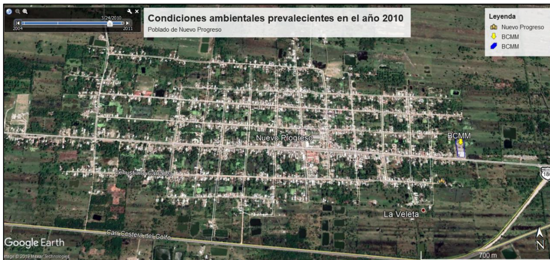
Figura 15.- Condiciones ambientales en el 2010 del poblado de Nuevo Progreso, se observa el crecimiento en la densidad poblacional y de menos espacio de vegetación. El sitio del proyecto ya constaba con la infraestructura para los servicios de almacén, oficinas administrativas y patio de maniobras.
