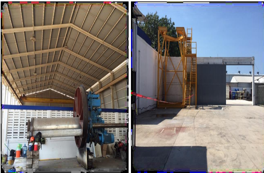
Figura 14. Área de Patio de Maniobras y Frigoríficos en el sitio del proyecto.
