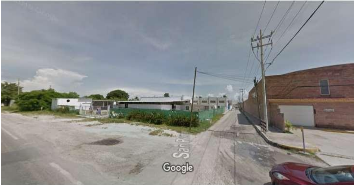
Figura 2.1. Aspectos del sitio del proyecto ubicado en la Avenida Isla de Tris, s/n, Polígono B, Colonia San Joaquín, Ciudad del Carmen, Campeche.
