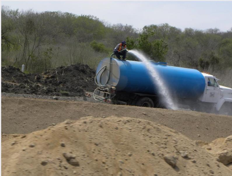
**Figura 10. Riego de la superficie para evitar el levantamiento de polvo**
