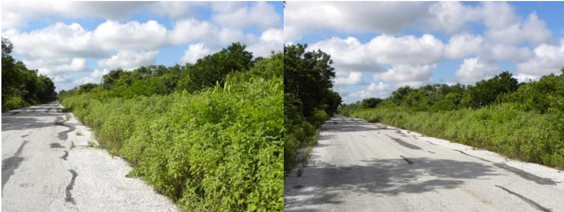
Figura 10. Condición actual del pavimento en el camino Lubna – Kikab – Laguna Grande, tramo del Km 0+000 al Km 86+000
