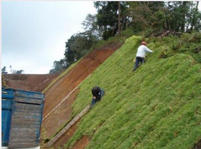
Figura 9. Ejemplo de siembra de pastos para la estabilización de taludes.
