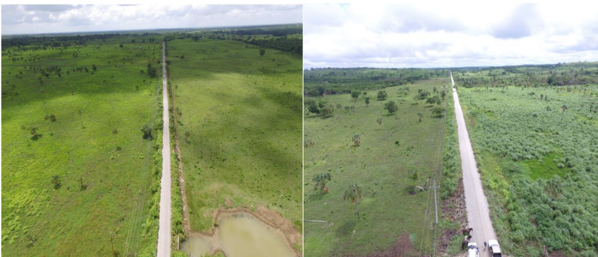
Figura 50. La modernización del camino no afectara significativamente superficies forestales, ya que actualmente se observan áreas con notables cambios de origen antropogénico, debido a las distintas actividades que se han llevado a cabo durante al menos los últimos 5 años.
