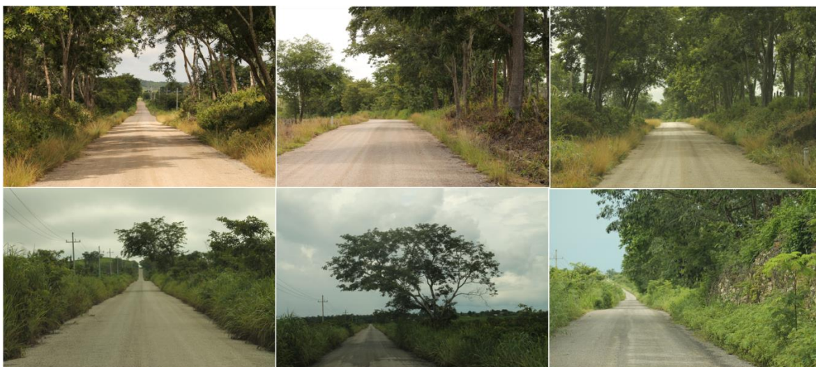
Figura 46. Las copas de algunos árboles que se observan aislados y dispersos sombream el camino, pero sus troncos se encuentran fuera de la LC, por lo que muchos árboles no resultaran afectados con la modernización del camino
