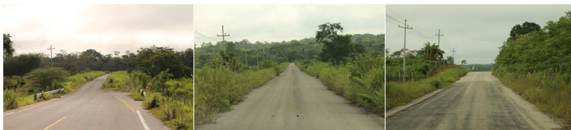
Figura 9. Vistas terrestres que muestran las condiciones generales del camino que pretende ser modernizado.
