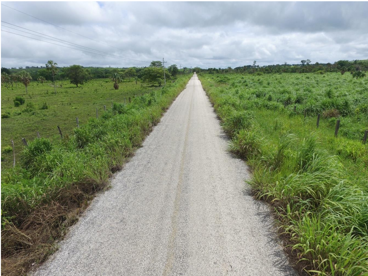
Figura 50. Camino actual que pretende ser modernizado.
