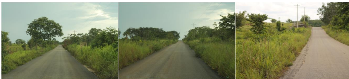
Figura 5. Vistas terrestres que muestran las condiciones generales del camino actual.
