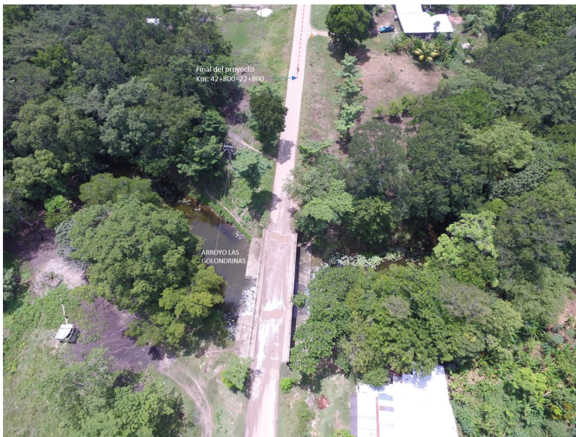
Figura 40. Arroyo las Golondrinas metros después del final del proyecto.
