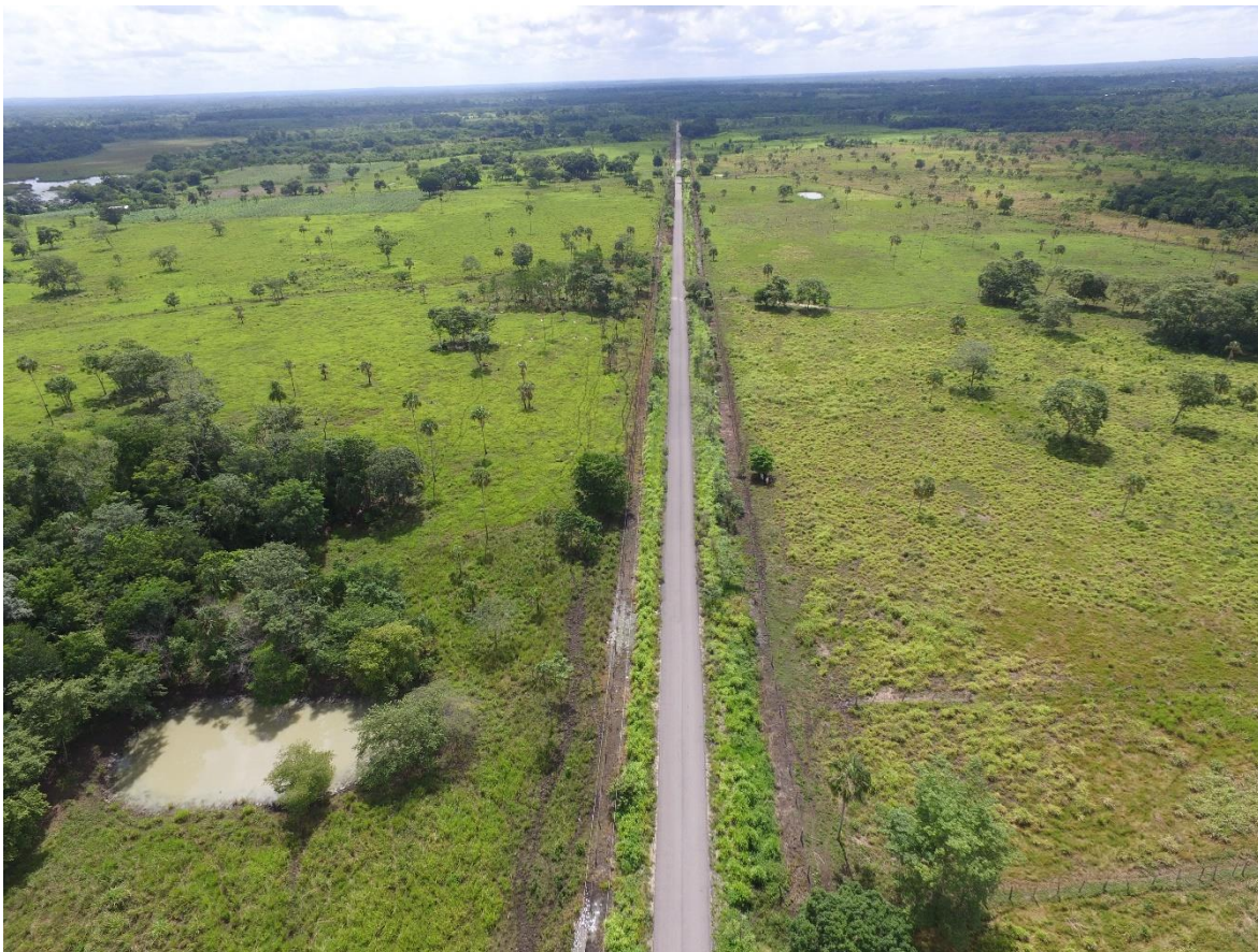
Figura 4. Vista aérea tomada con un Drone que muestra las condiciones generales del camino que pretende ser modernizado.
