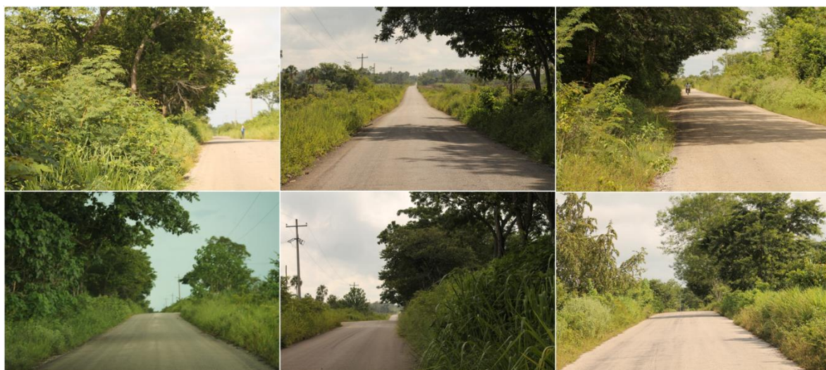
Figura 30. Las copas de algunos árboles somborean el asfalto, pero sus troncos se encuentran fuera de la LC, por lo que muchos árboles no resultaran afectados con la modernización del camino.
