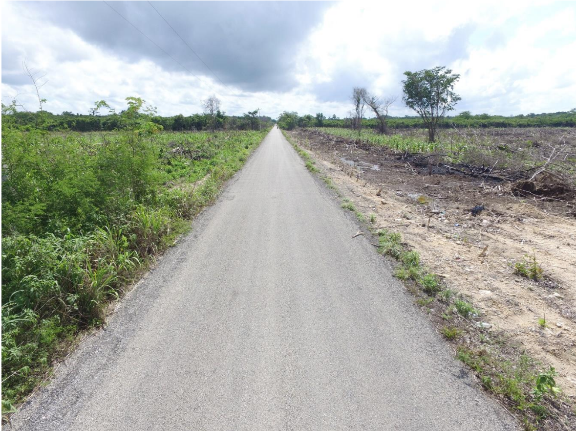
Figura 44. Camino actual que pretende ser modernizado.
