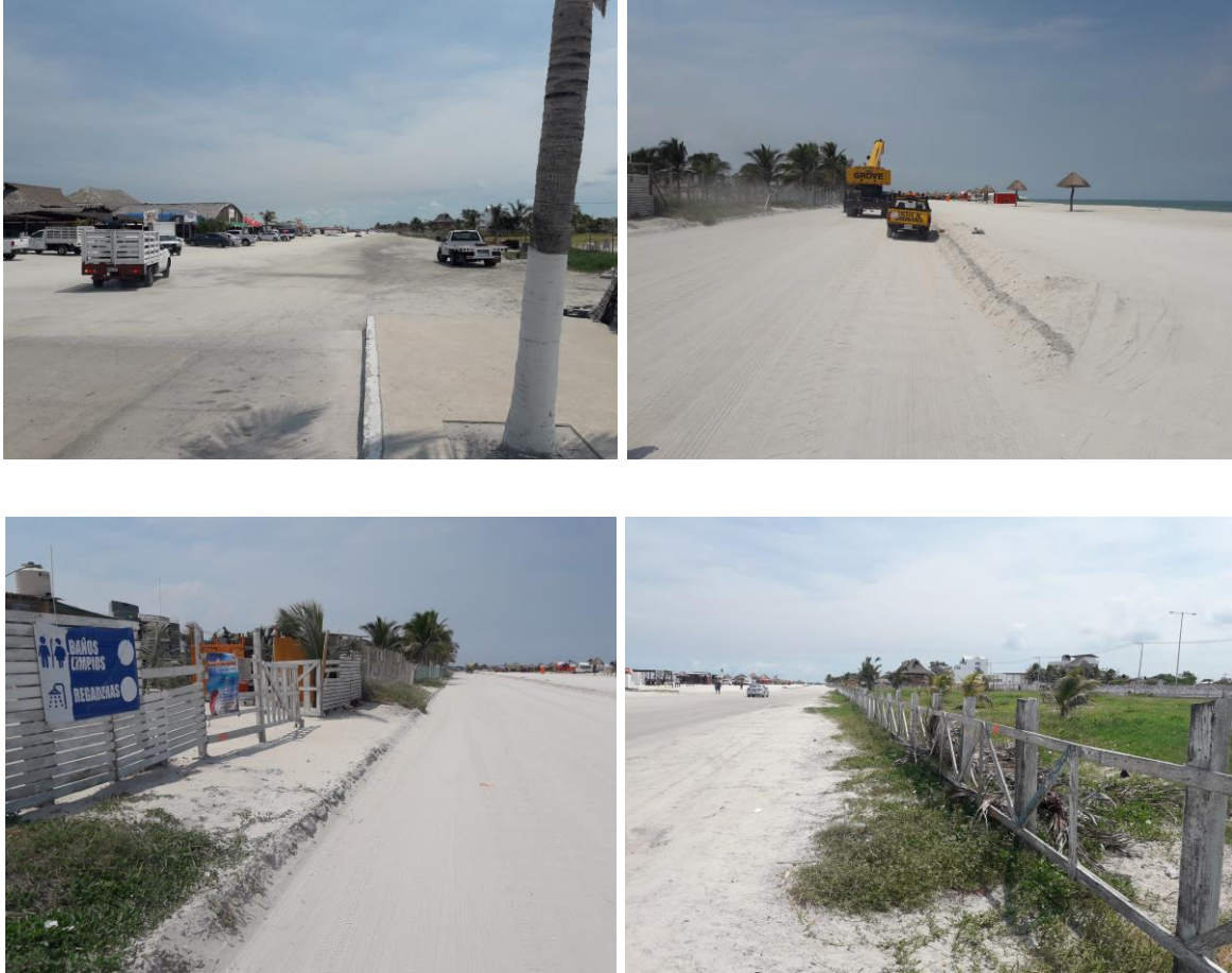
Fotografías del sitio del proyecto en sus condiciones originales.
